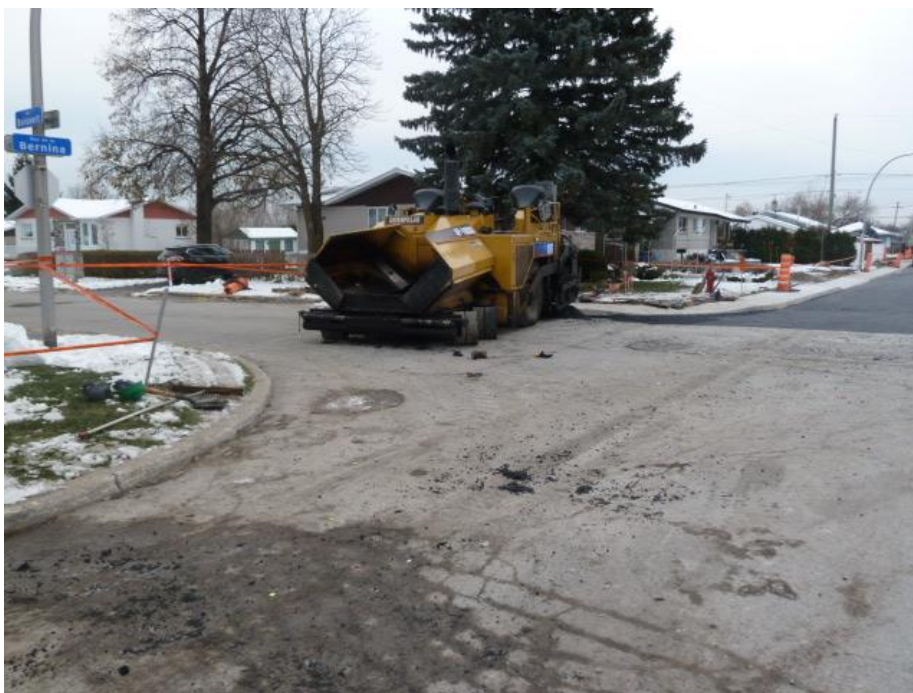
Photo 1 : Paveuse AP1000D après l'accident (source CNESST)
