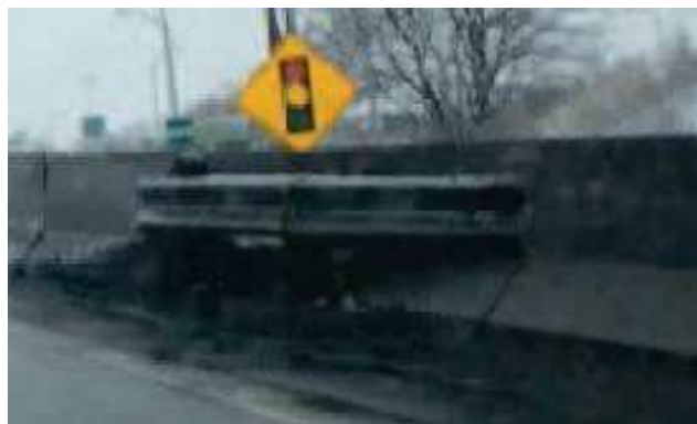
Photo 2 - Glissière remplacée
