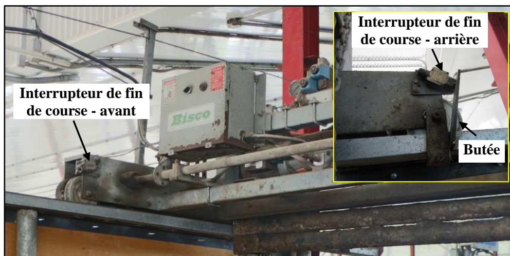
Figure 8 : Interrupteurs de fin de course
