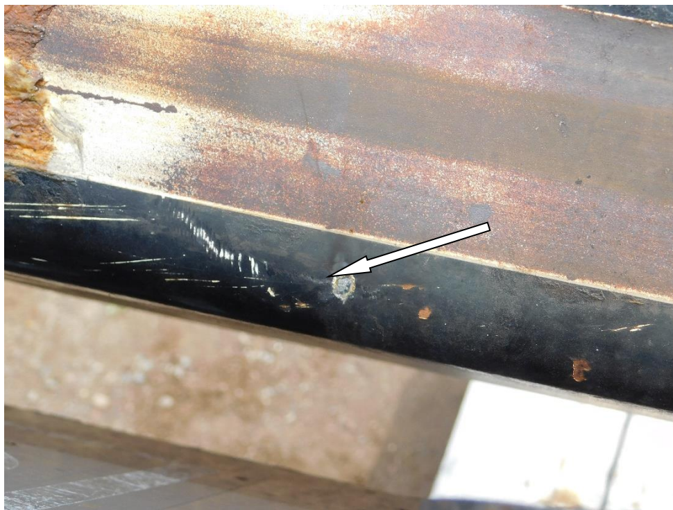
Photo 10 : Point de contact par contournement (arc probable) plausible au haut du bras articulé vis-à-vis la zone dénudée de la photo 9 (Source : CNESST).
