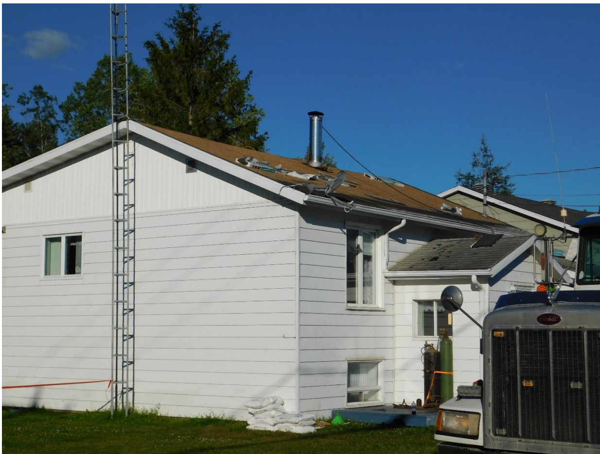
Photo 2 : Vue partielle du bâtiment en rénovation. (Source : CNESST)
