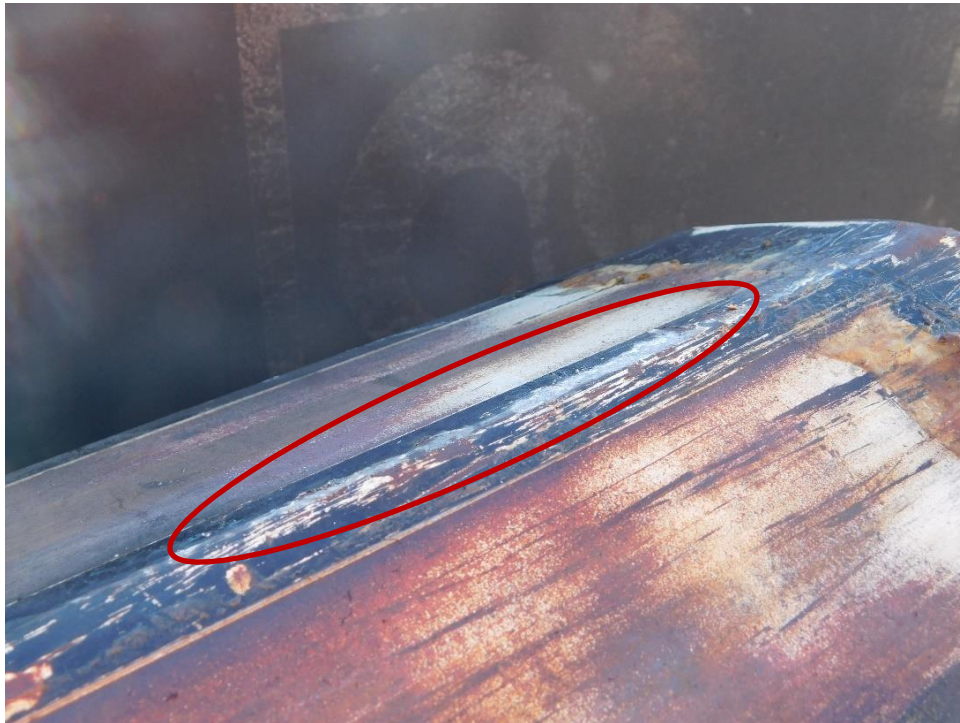
Photo 9 : Zone de contact du fil avec le bras articulé. La zone est dénudée (Source : CNESST).
