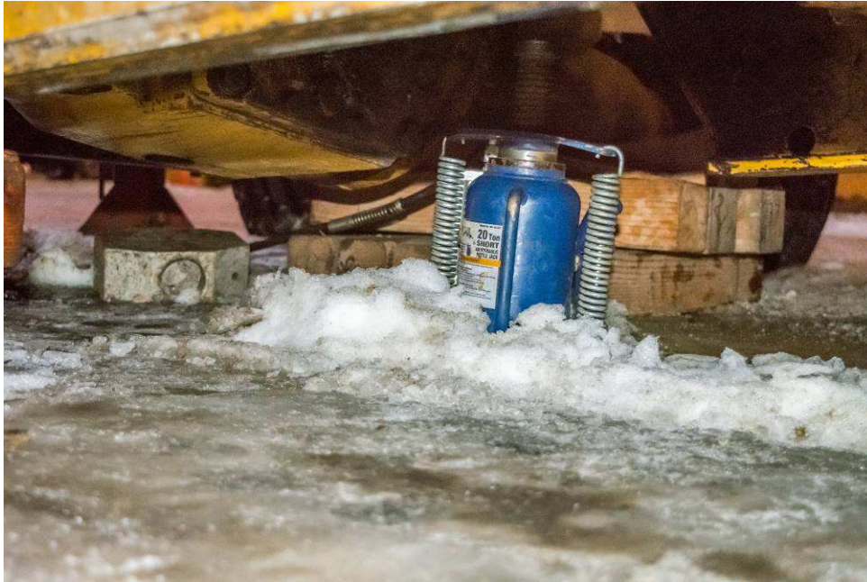
Photo 4 : État du sol autour du cric Source : CNESST
