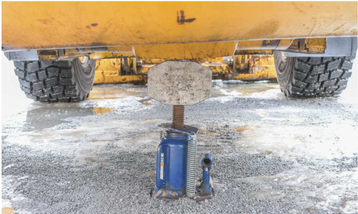
Photo 12 : Point de levage utilisé par le travailleur Source : CNESST
