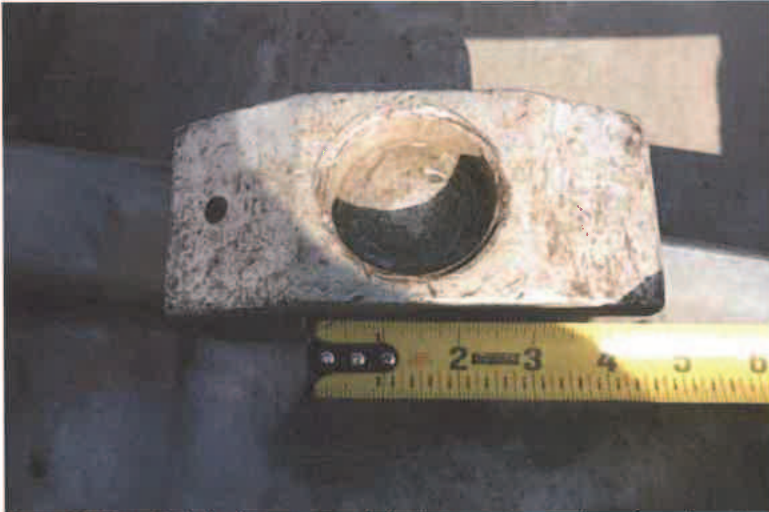
Photo 48 :Vue générale du mesurage de la largeur totale de la surface d'appui au moment de l'accident.
