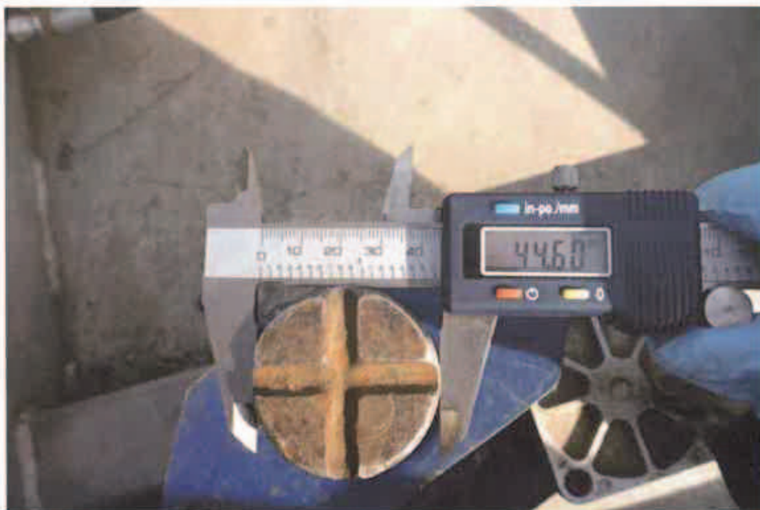
Photo 30 :Vue générale du mesurage du diamètre de l'extrémité supérieure de la vis d'approche.
