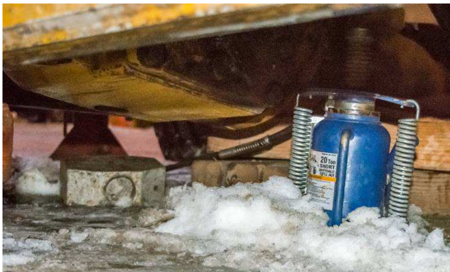
Photo 13 : Position du cric et du bloc de rallonge après la chute de la chargeuse Source : CNESST
