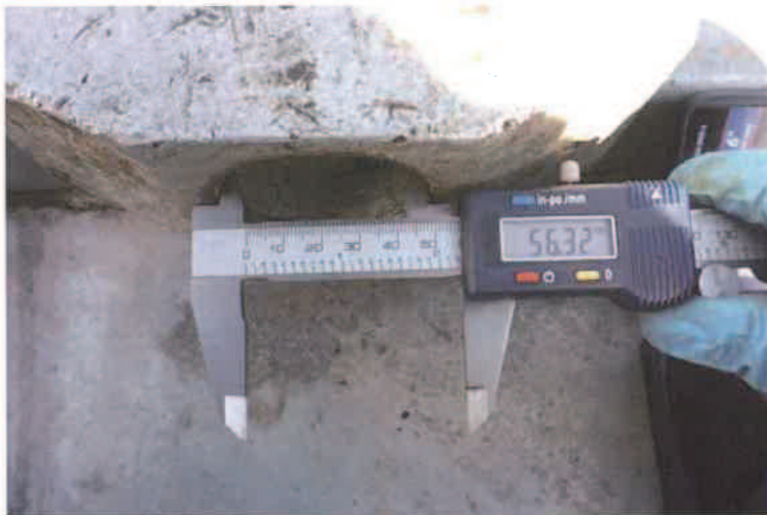
Photo 45 :Vue générale du mesurage du diamètre intérieur de l'ouverture de la face inférieure du bloc de rallonge (il s'agit de l'ouverture utilisée lors de l'accident).
