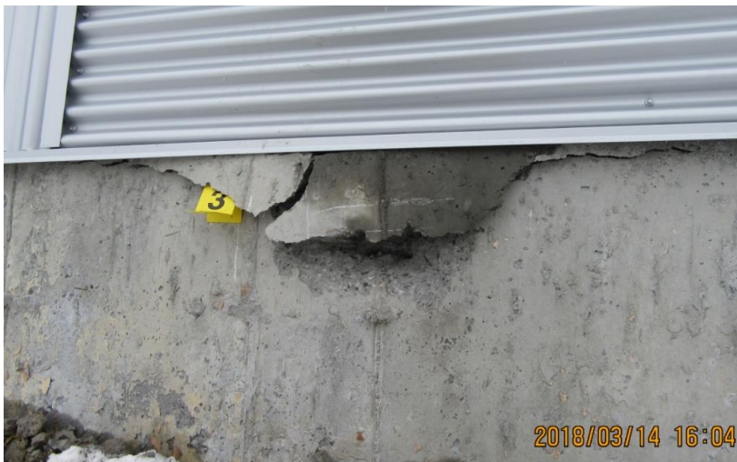
Photo #4 : Vue du mur de béton après l'arrachement d'un groupe d'ancrages
