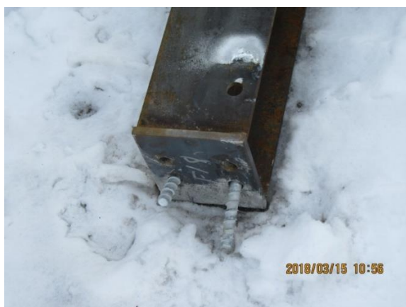
Photo n° 9 : Poutre W6 avec les 2 ancrages du bas
