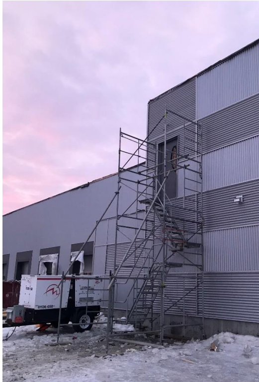
Photo n° 4 : Escalier de chantier Source : Immodev
