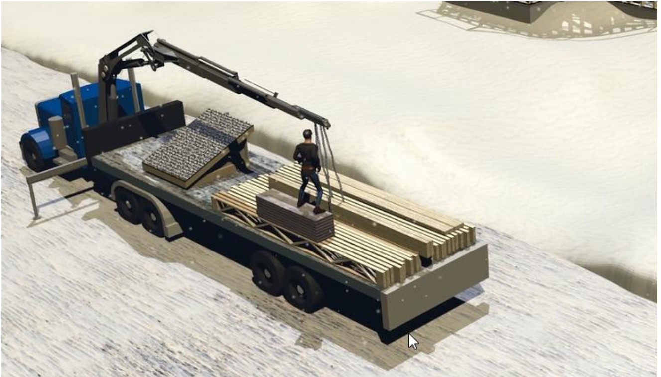
Figure 3 : Extrait de la simulation lors du levage des poutres (Source : CNESST)
