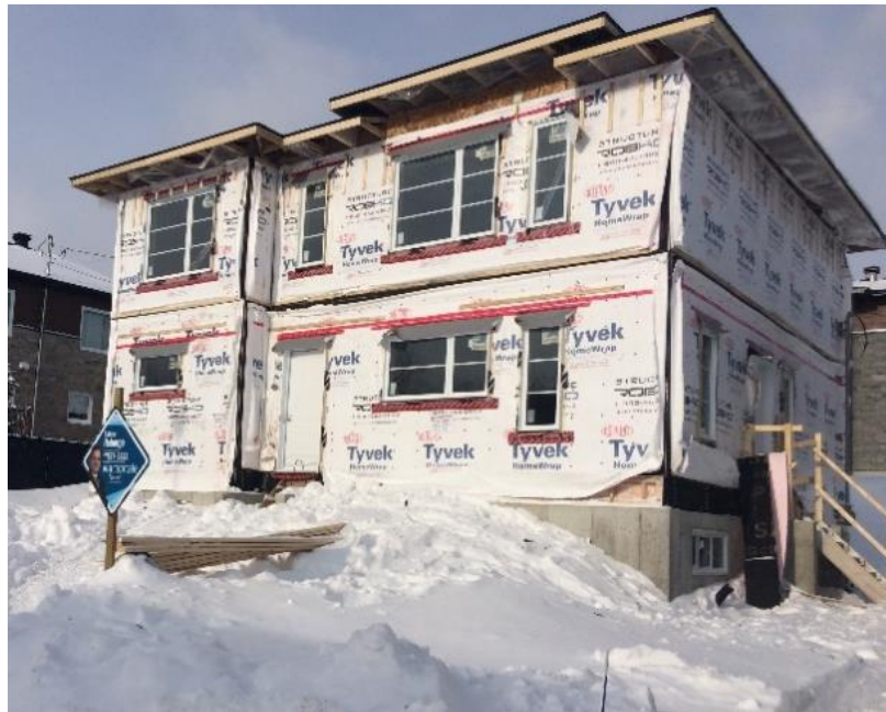
Photo 1 : Le jumelé en construction, le 14 décembre 2017 (Source : CNESST)
