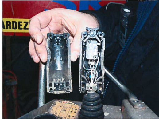
Photo no.7 Relais à l'intérieur du levier de commande
