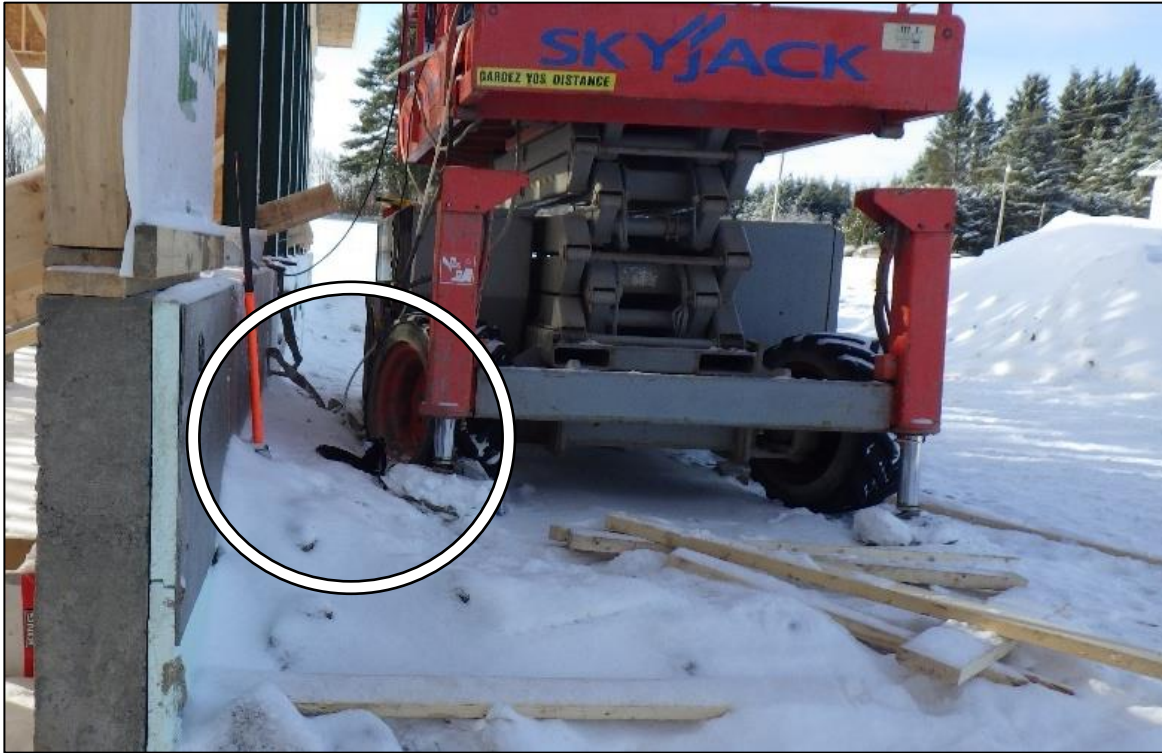
Photo 6. Amoncellement de matériel terre/neige/glace entre la plate-forme et le mur en façade (Source : CNESST)
