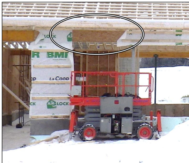
Photo 2. Zone des travaux sur le mur en façade, au moment de l'événement (Source : CNESST)
