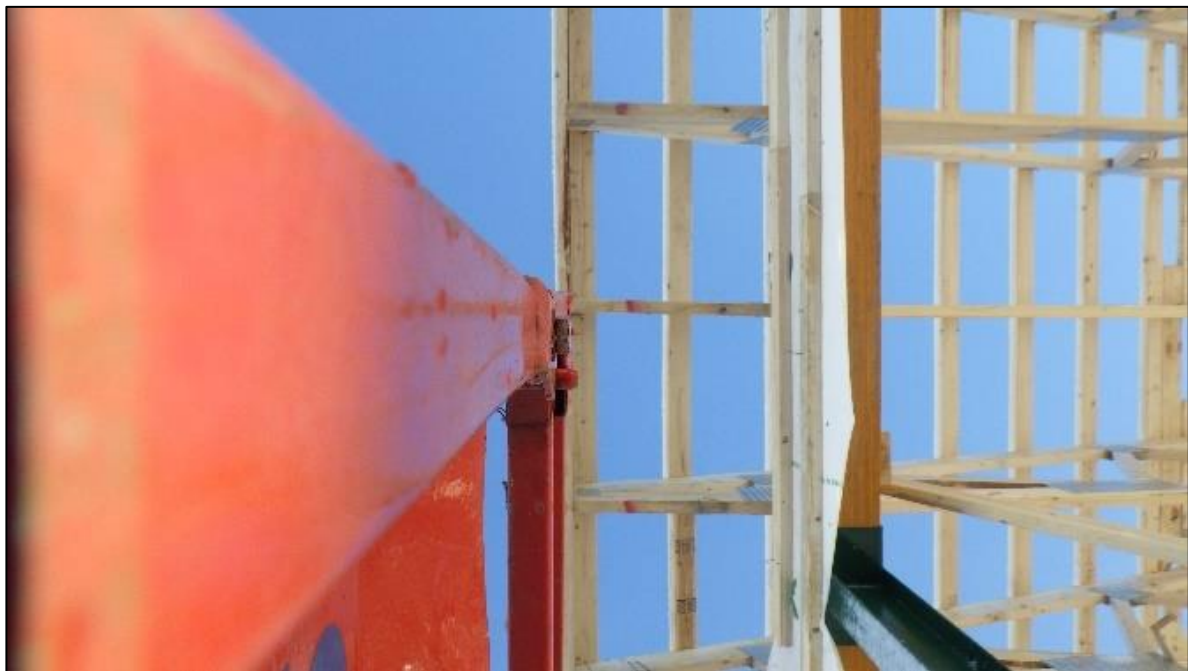
Photo 7. Positionnement de la plate-forme par rapport au mur et au débord de toit. Vue en contre-plongée. (Source : CNESST)
