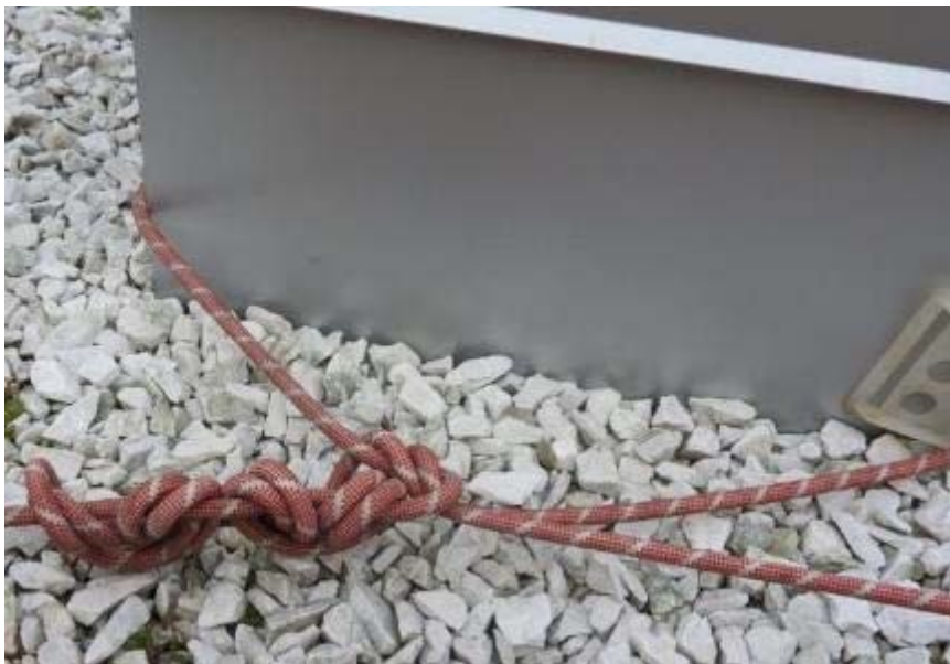
DSCN1515.jpg - Corde non protégée des arêtes de la tôle
