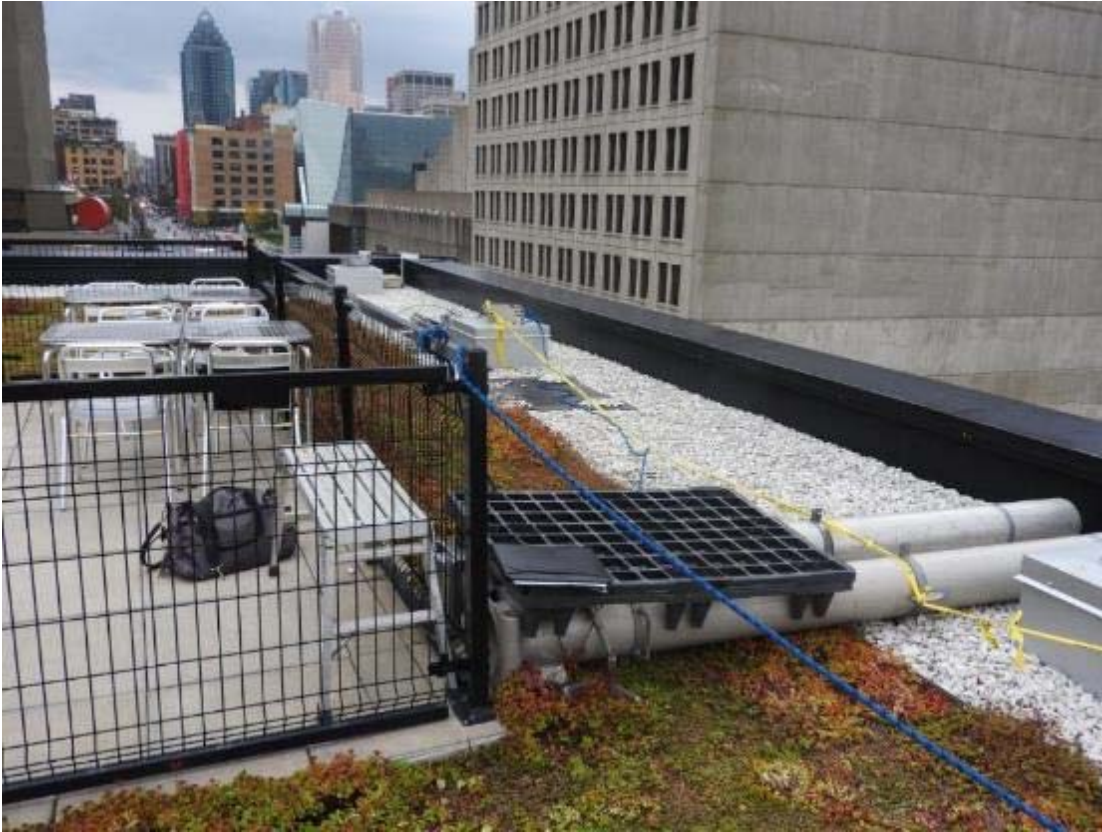
DSCN1531.jpg - La ligne de vie est attachée au garde-corps de la terrasse.
