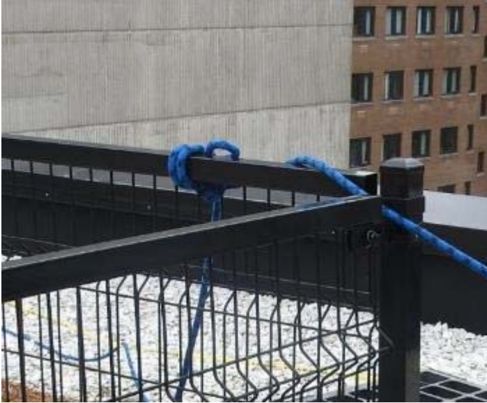
DSCN1540.jpg - La ligne de vie est attachée au garde-corps de la terrasse.
