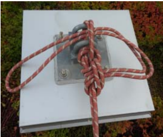
DSCN1505.jpg – La corde est ancrée à la base du bossoir sans l'utilisation d'un mousqueton.
