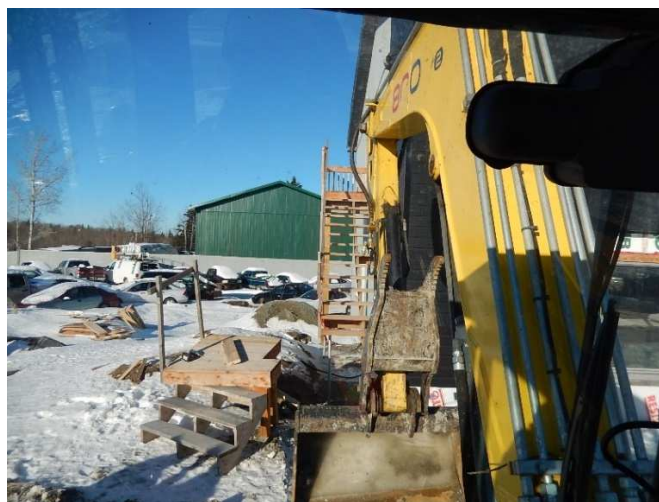
Photo 8 : Vision de l'opérateur de pelle mécanique lorsqu'il œuvre à l'épandage du gravier sous l'escalier
