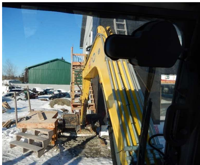
Photo 9 : Autre vision à partir du siège de l'opérateur de la pelle mécanique lorsqu'il procède à l'épandage de gravier sous l'escalier
