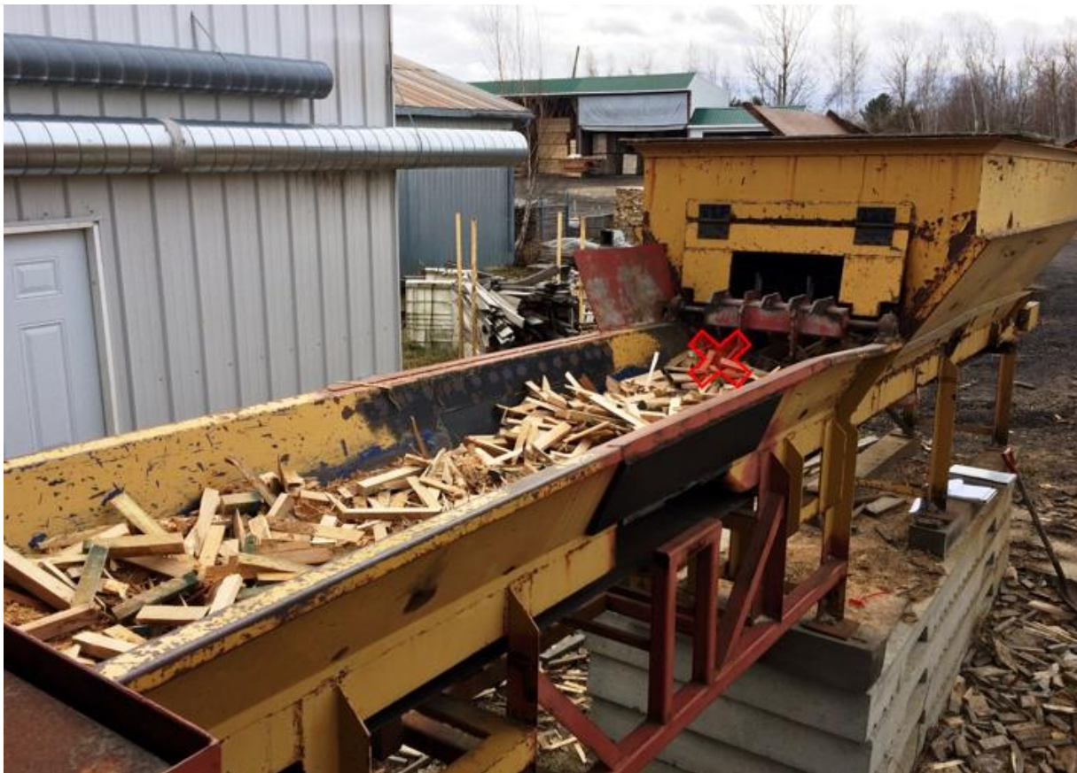
Photo 1 : Lieu de l'accident Source : CNESST
