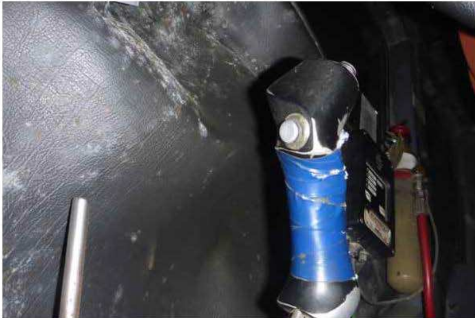
Photo 39 : Vue générale de l'interrupteur du point mort de la transmission.
