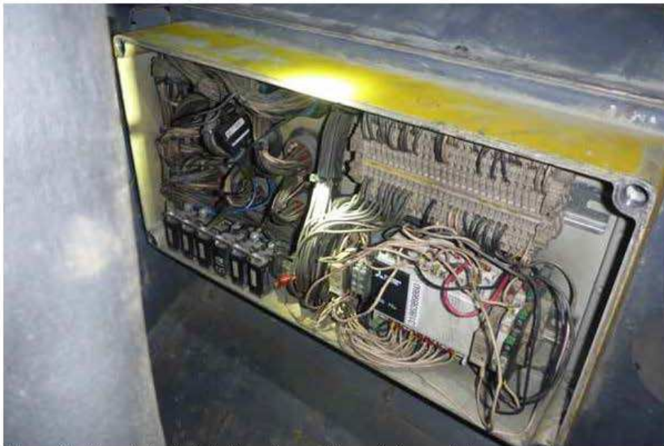
Photo 42 : Vue générale du boîtier de contrôle après le retrait du couvercle.
