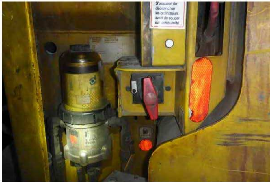
Photo 49 : Vue générale de l'ouverture du coupe-circuit général.
