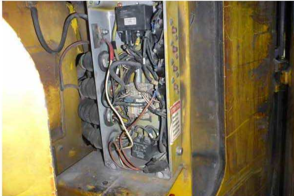
Photo 47 :Vue générale du boîtier de distribution après le retrait du couvercle.
