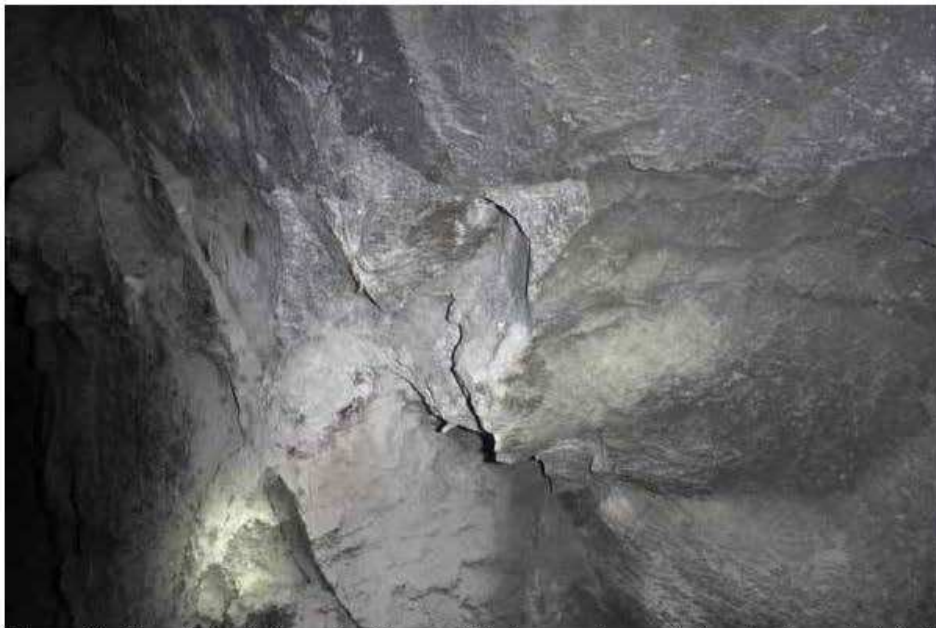
Photo 14 : Vue générale du point d'impact inférieur sur le mur de la galerie et de la baie de forage.
