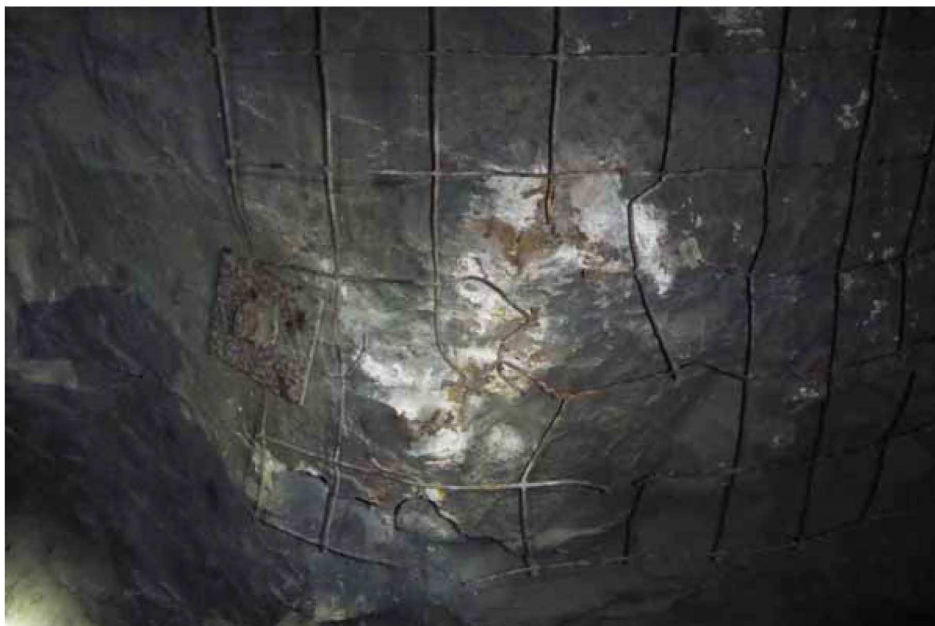
Photo 12 : Vue générale du point d'impact supérieur sur le mur de la galerie et de la baie de forage.
