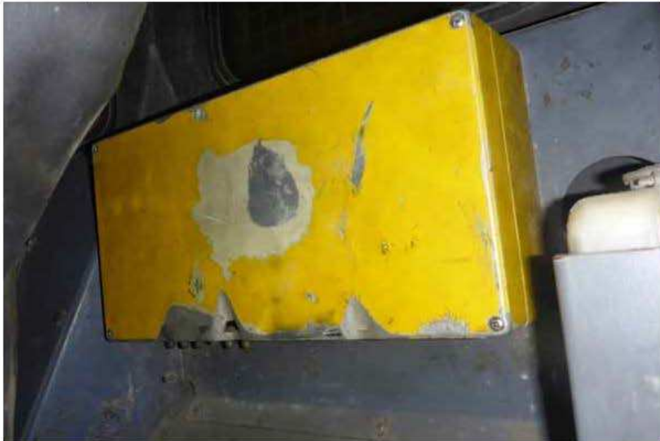
Photo 41 : Vue générale du boîtier de contrôle localisé derrière le siège de la cabine.
