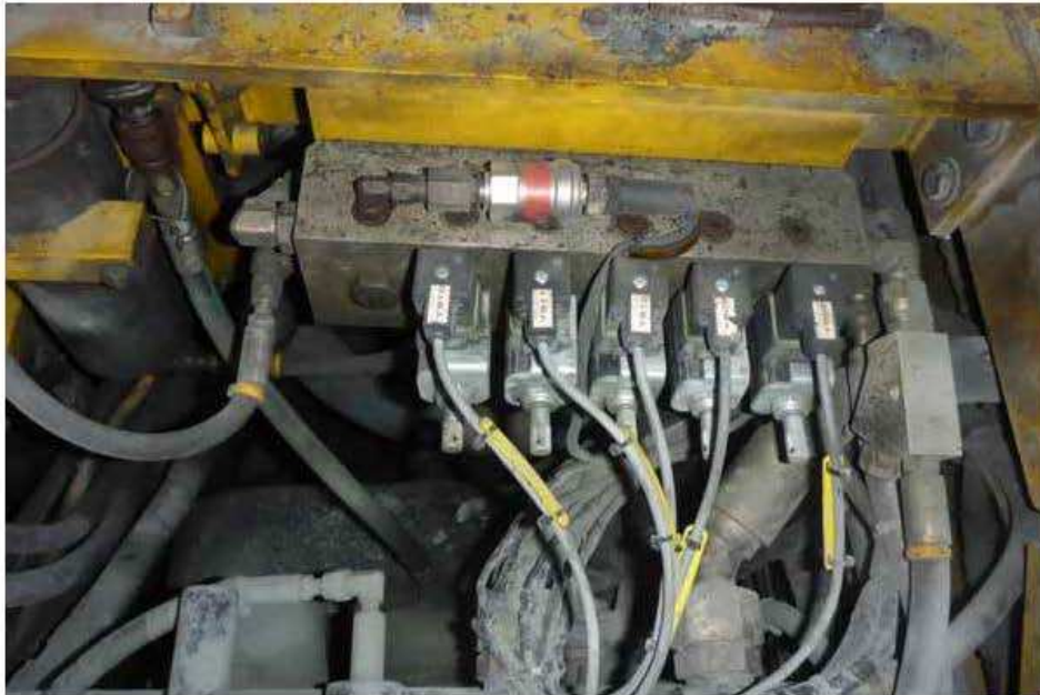
Photo 29 : Vue générale des relais pneumatiques de la transmission.
