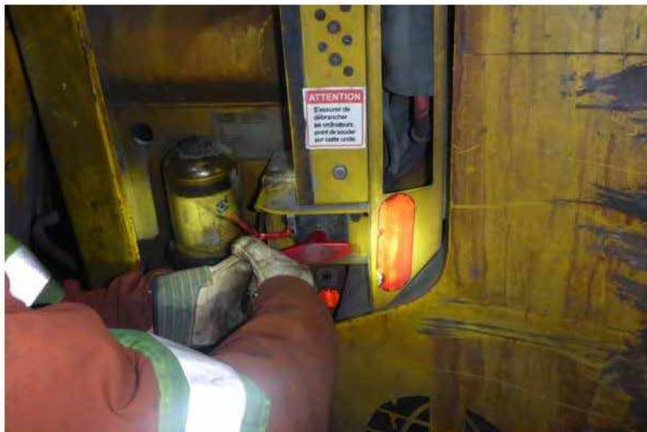
Photo 48 :Vue générale du coupe-circuit général avant le retrait du sceau de la CNESST.
