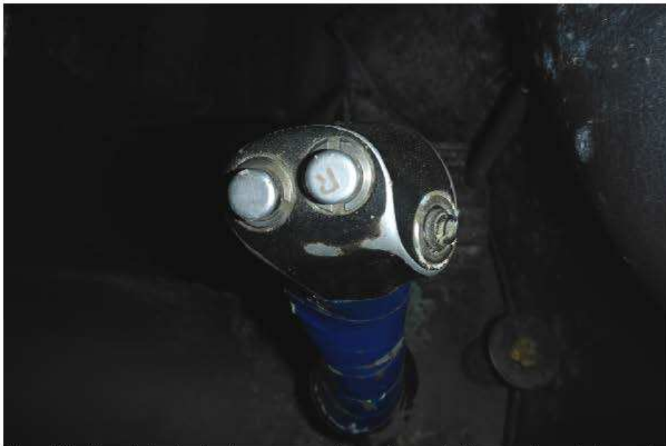
Photo 38 : Vue générale des interrupteurs électroniques de l'avance (gauche), marche arrière (centre) et de l'avertisseur sonore (droit).
