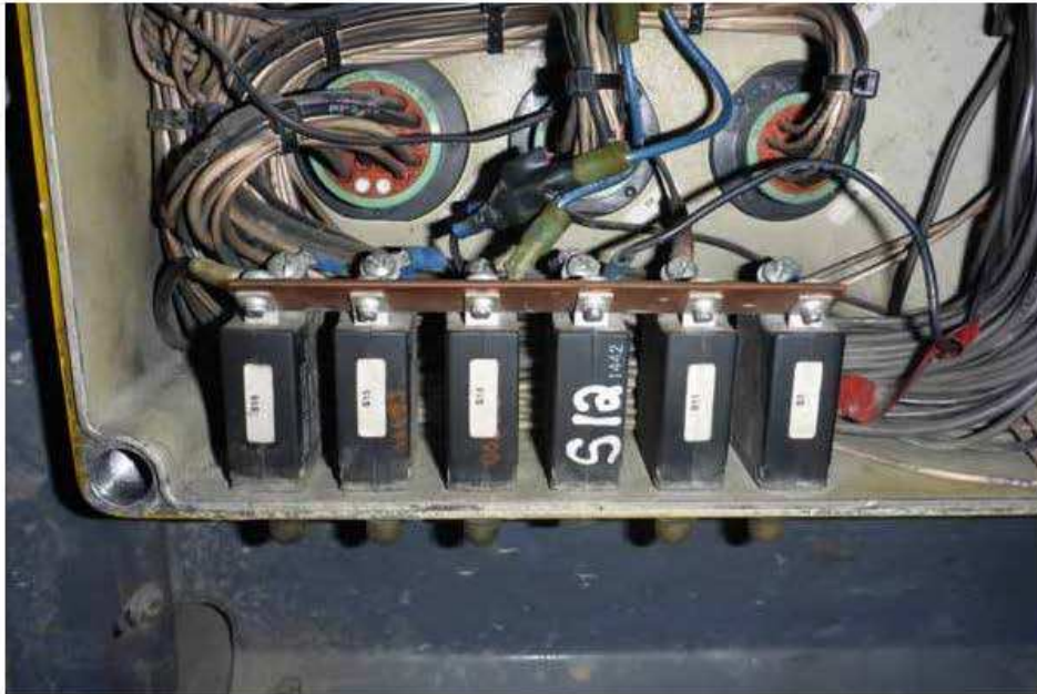
Photo 43 : Vue générale des relais électriques du boîtier de contrôle.
