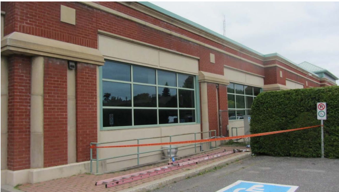
Photo 1 : Lieu de l'accident (source : CNESST)
