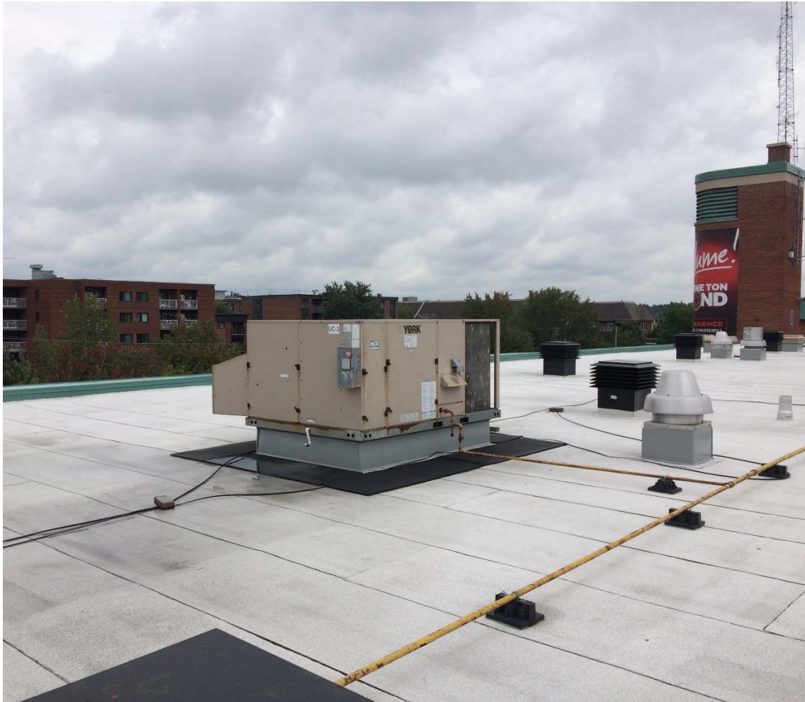
Photo 4 : Unité de climatisation (source : CNESST)
