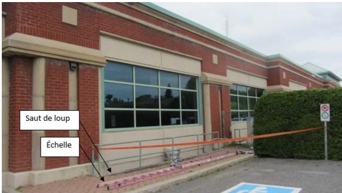
Photo 2 : Position de l'échelle au moment de l'arrivée des premiers répondants (source : CNESST)
