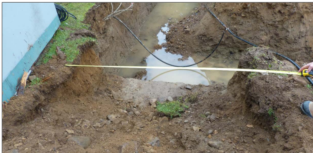
Photo 5 : Zone de creusement au moment de l'accident Source : CNESST
