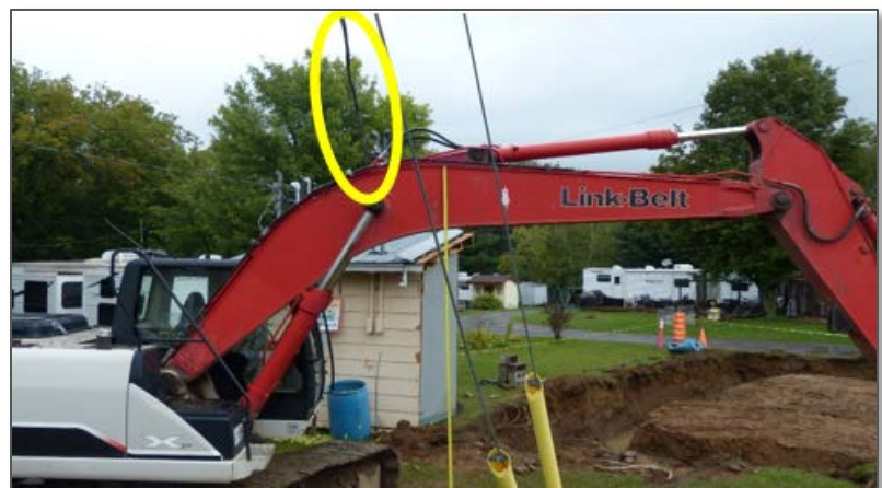
Photo 4 : Positionnement du fil électrique Source : CNESST
