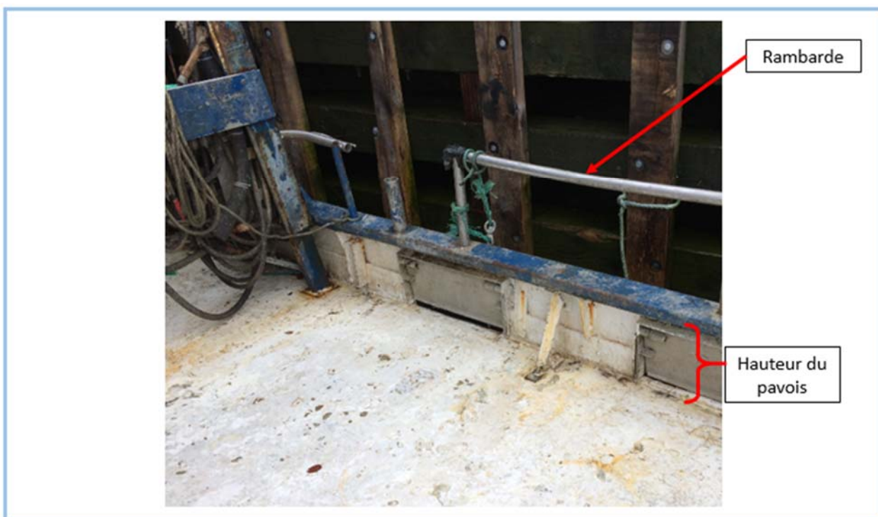
Photo 7 – Rambarde tribord sur le pont de pêche (source : CNESST)
