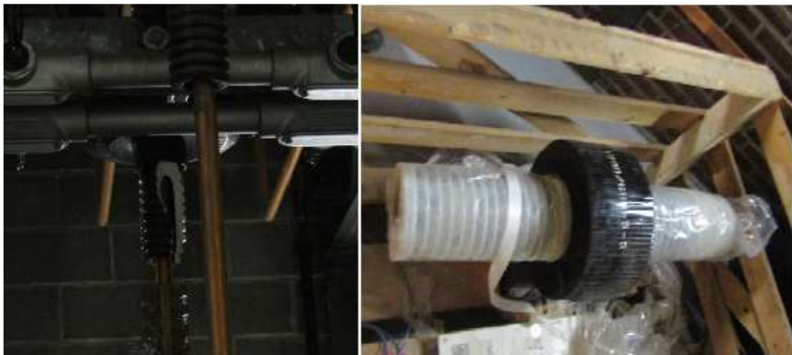
Photo 8 : Bris de l'isolateur (Source : CNESST) Photo 9 : Nouveau transformateur (Source : CNESST)
