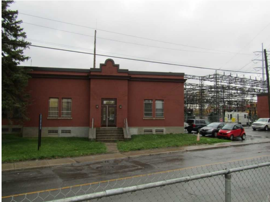
Photo 2 : Poste Rockfield (Source : CNESST)
