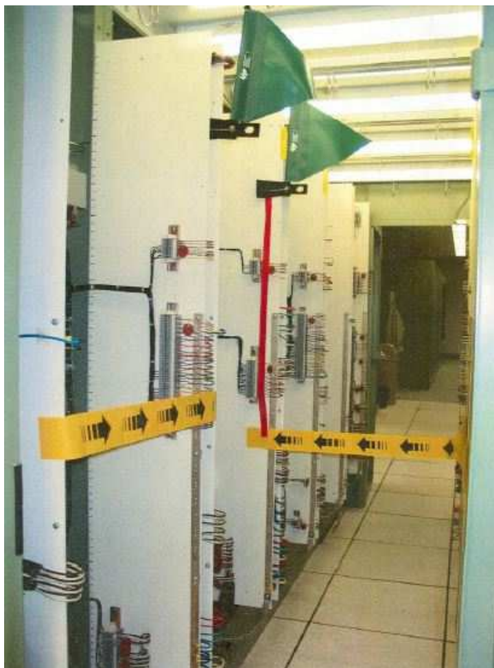
Photo 16 : Exemple de balisage (source : Hydro-Québec)
