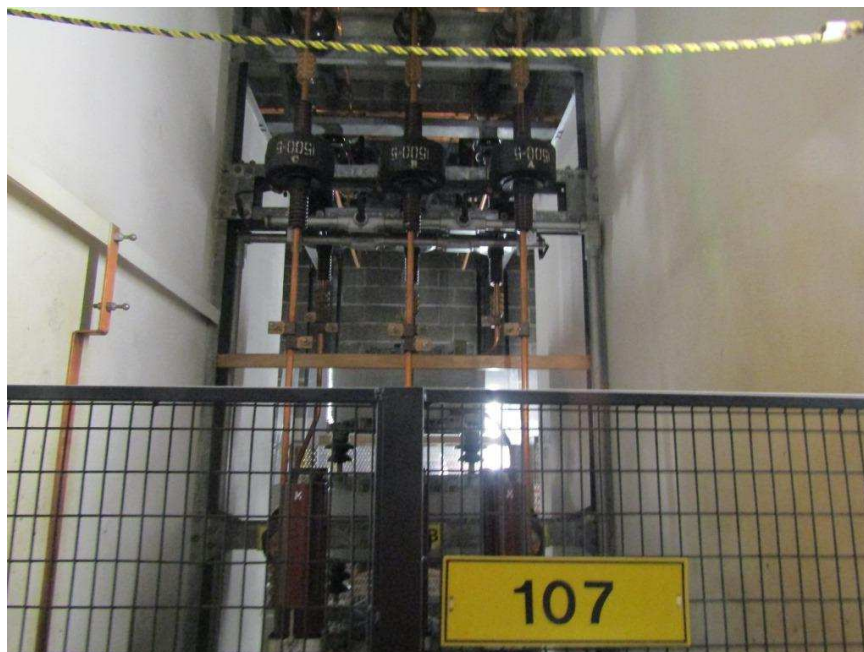
Photo 14 : Cellule sous tension (sans câble de mise à la terre) (Source : CNESST)
