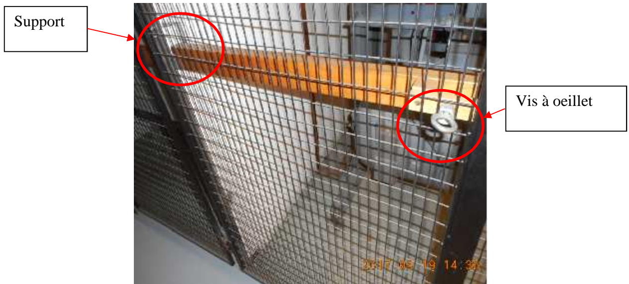
Photo 11 : Porte des cellules (Source : CNESST)
