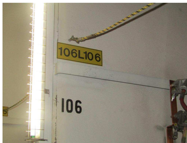
Photo 12 : Marquage sur le mur de la cellule (Source : CNESST)
