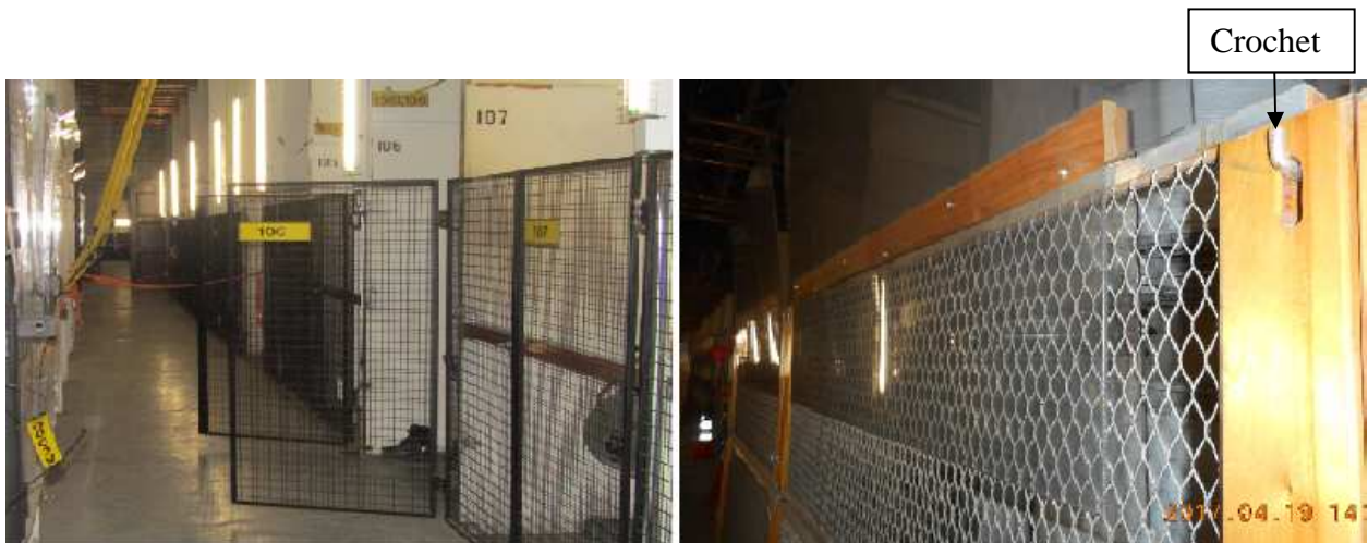
Photo 4 : Corridor central (Source : CNESST)
