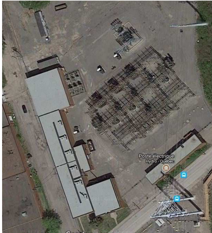
Photo 3 : Poste Rockfield (Source : Google)
