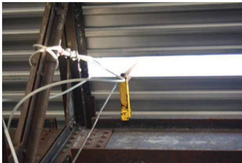
Photo 3 : Installation de l'ancrage à l'extrémité est du système d'ancrage continu flexible (source : CNESST)
