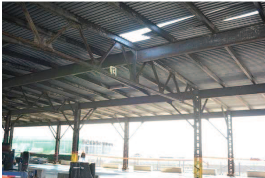
Photo 1 : Position du platelage métallique après l'accident (source : CNESST)
