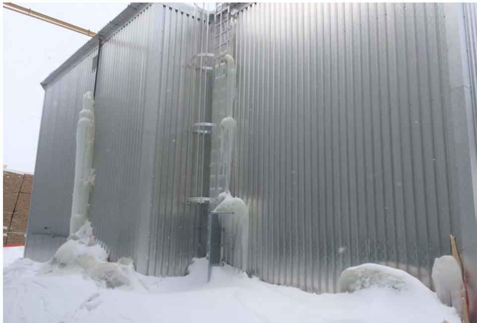
**Photo 7 : Glace accumulée lors des deux premiers cycles de séchage (source : CNESST)**
