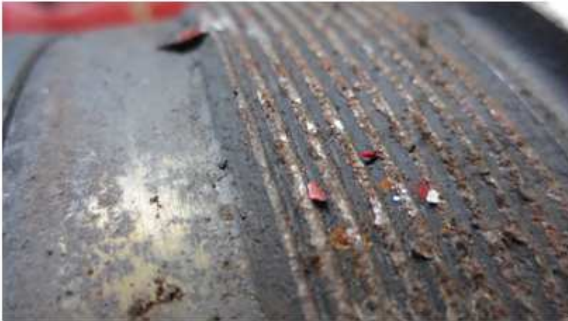
Photographie 6 : Présence de rouille dans les filets
