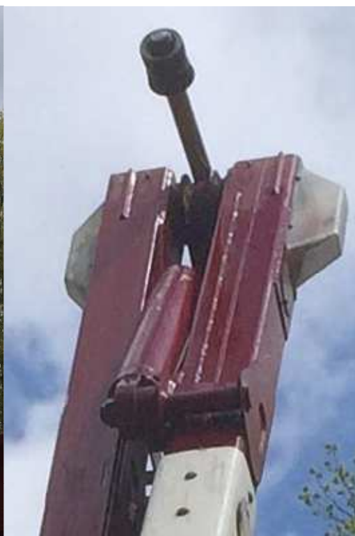
Photo 6 : Vue rapprochée du piston sorti du vérin (Source : CNESST)
