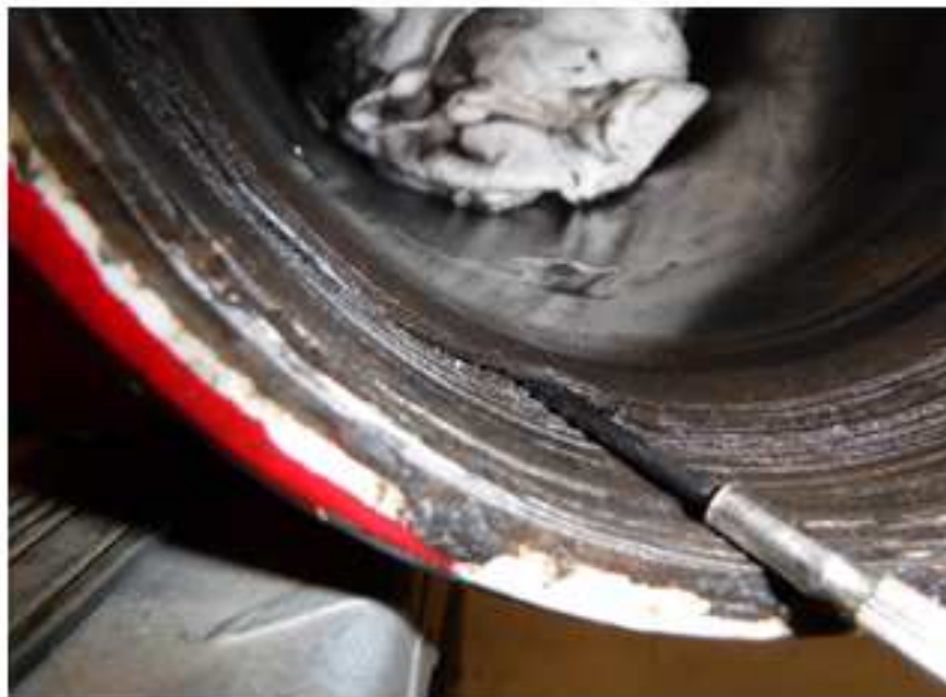
Photographie 13 : Partie métallique de filet entre deux filets
