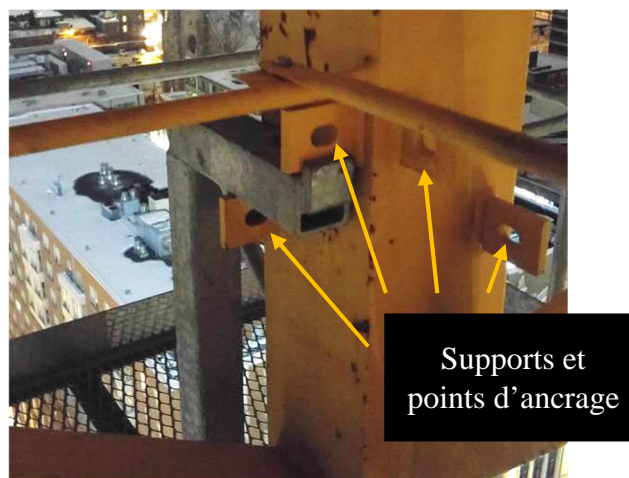
Photo 9 : Supports de plate-forme le 14 décembre 2016 Source : CNESST
