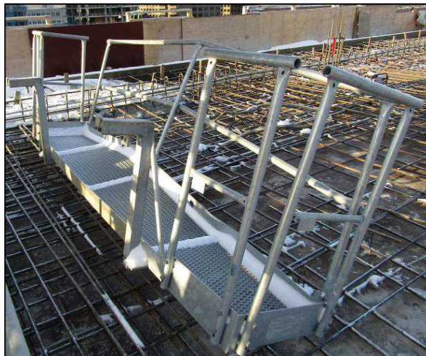
Photo 1 : Plate-forme de montage à la suite de l'accident Source : CNESST
