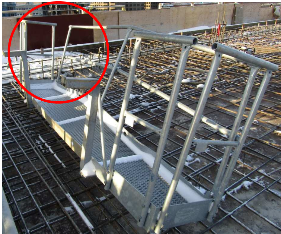
Photo 7 : Zone de coincement sur la plate-forme. Source : CNESST
