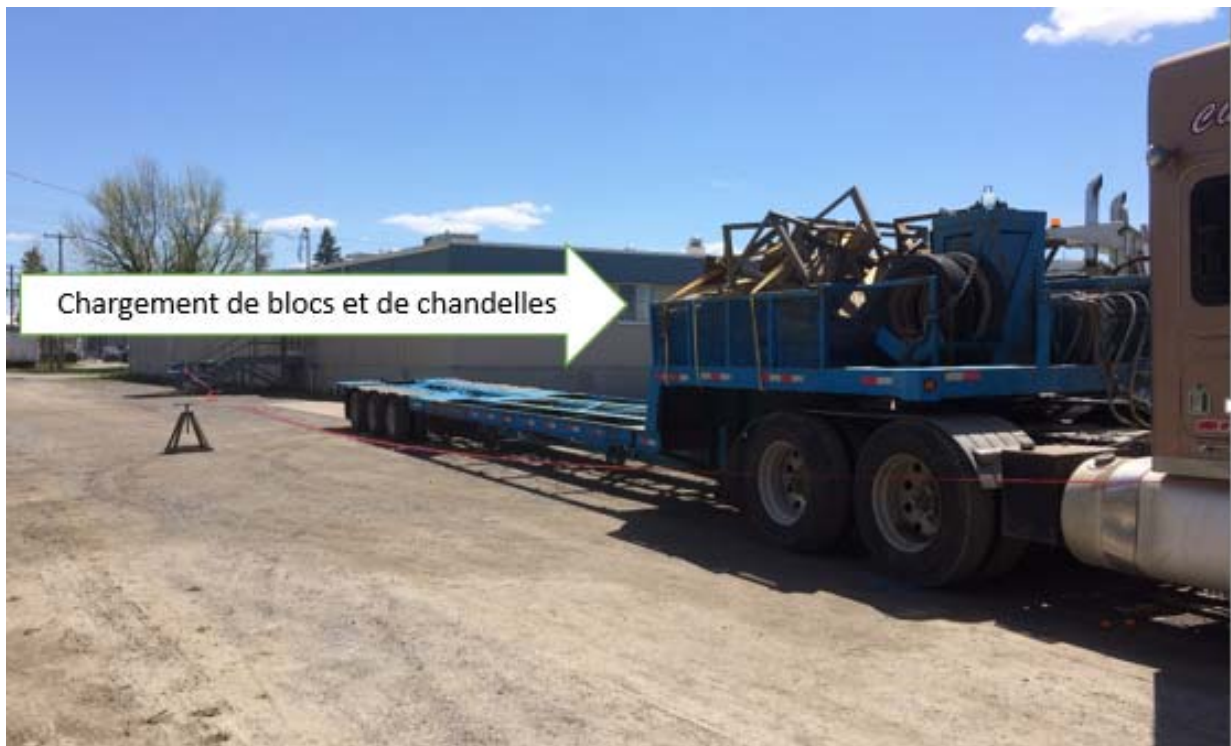
Photo 3 : Blocs et chandelles pour l'installation des locaux modulaires (Source : CNESST)
