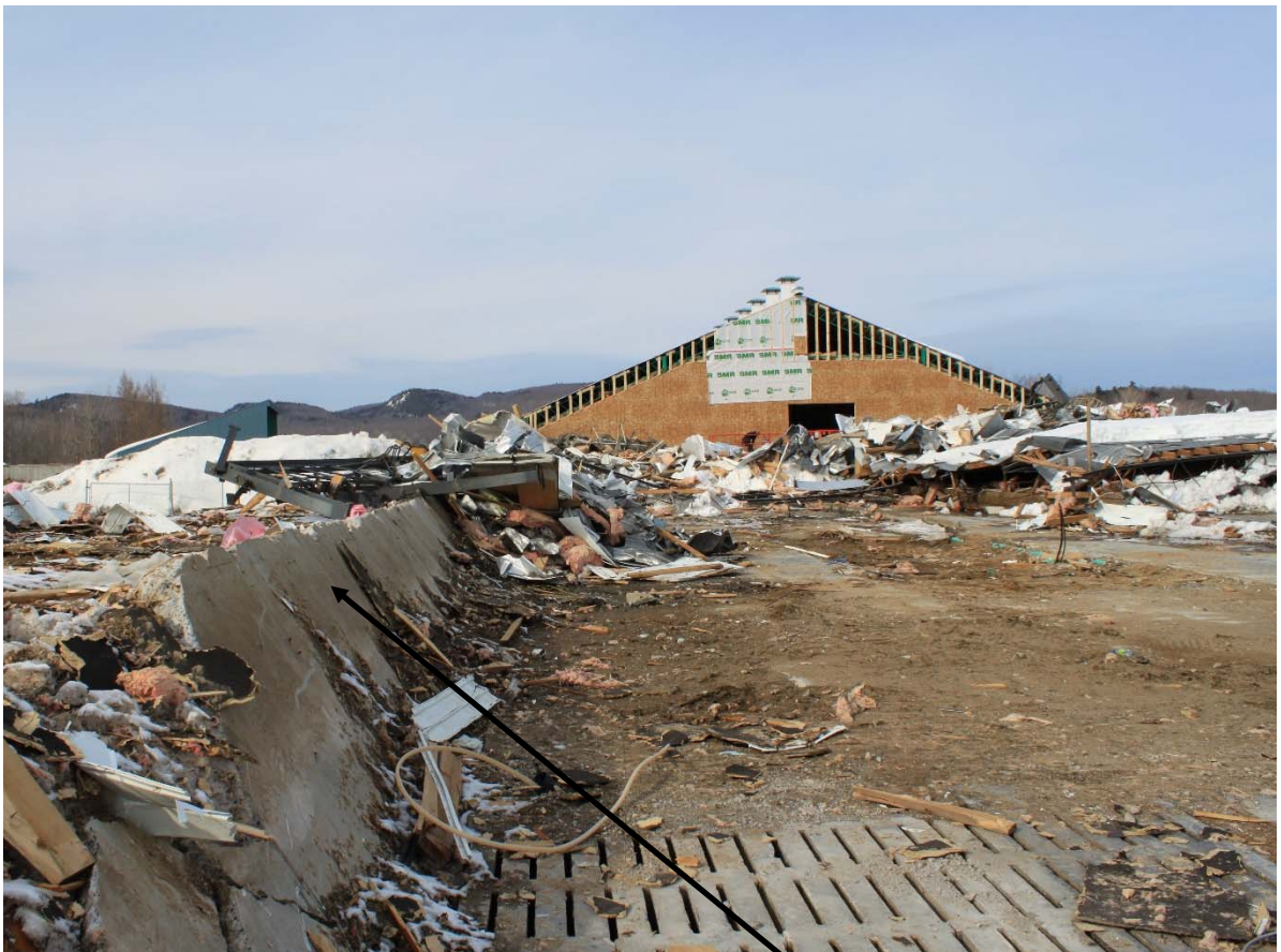
Mur de fondation versé vers l'extérieur
