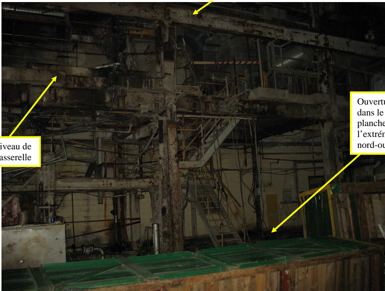
Photo 5 : Portion de la passerelle où se déroulent les travaux près de l'extrémité nord-ouest. Source : CNESST
