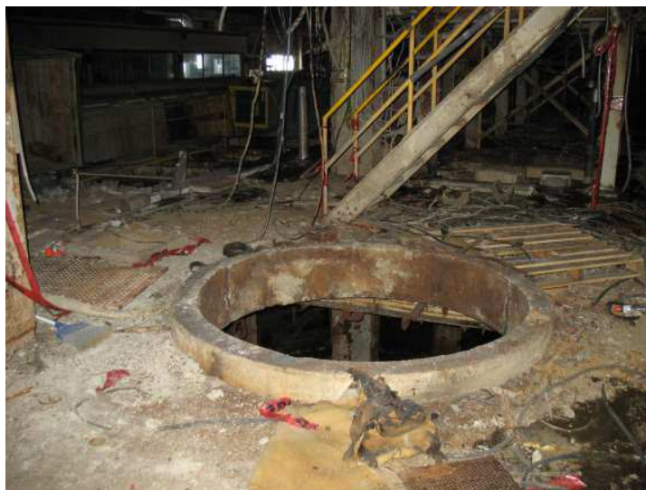
Photo 1 : Ouverture dans le plancher du RDC (extrémité nord-ouest, secteur machine C) Source : CNESST
