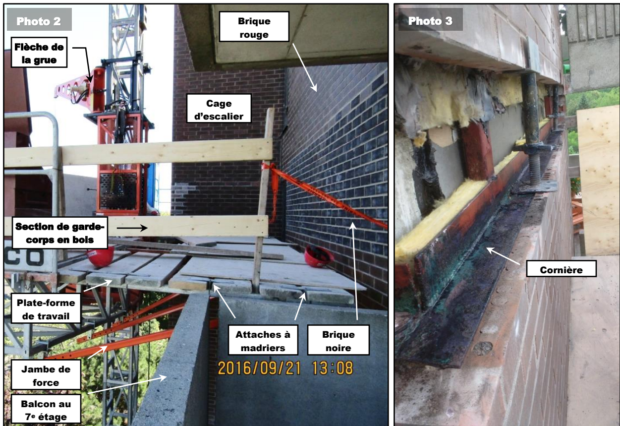
Photo 2 : Rangs de brique noire à remplacer. (Source : CNESST) Photo 3 : Exemple d'une cornière en cours de restauration sur le chantier. (Source : Construction Dion & Fils)
