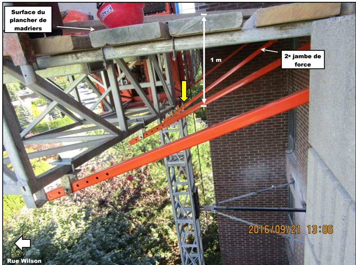
Photo 9 : Aperçu des quatre jambes de force (de couleur orange) sous le plancher de madriers de la plate-forme. (Source : CNESST)
