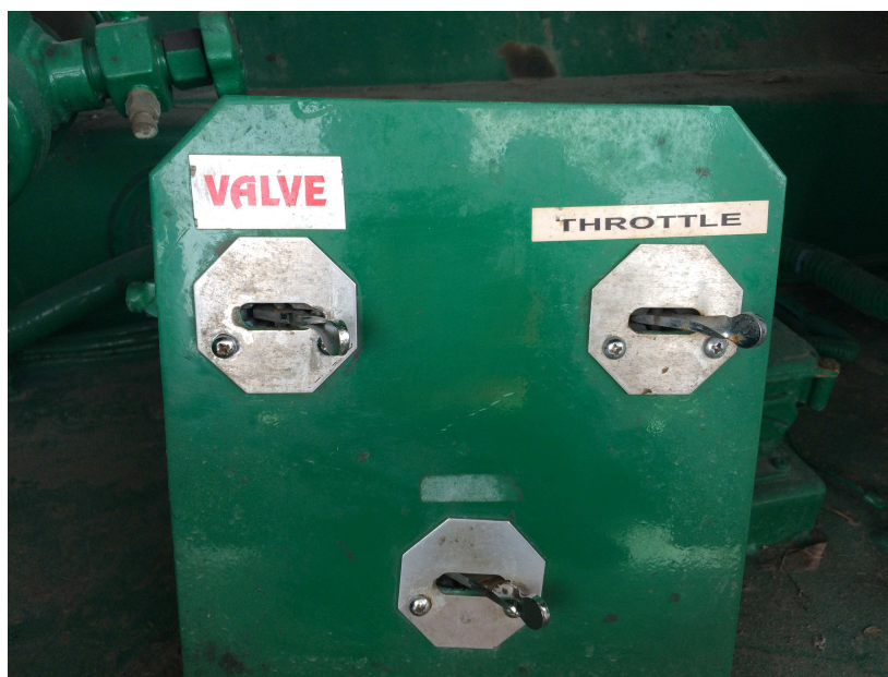
Photo 11 : Interrupteurs du camion-citerne #5569 en mode « off » (Source CNESST)
