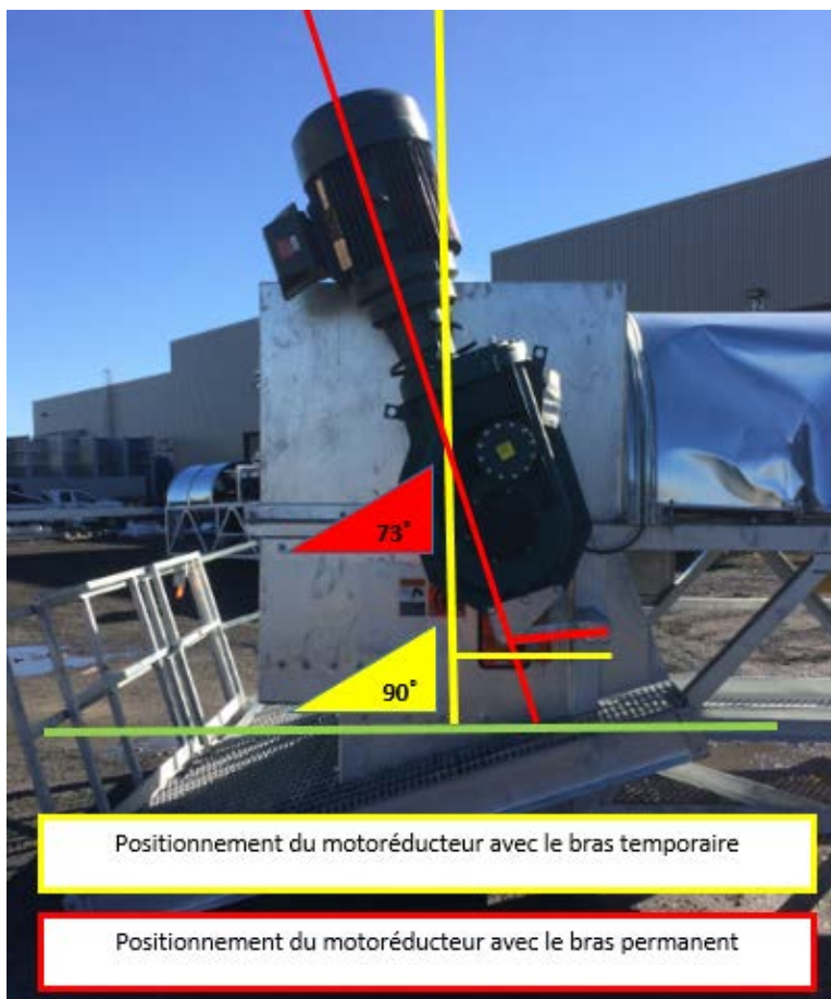
Photo 11 : Inclinaison du motoréducteur en fonction du bras de retenue permanent Source : CNESST.
