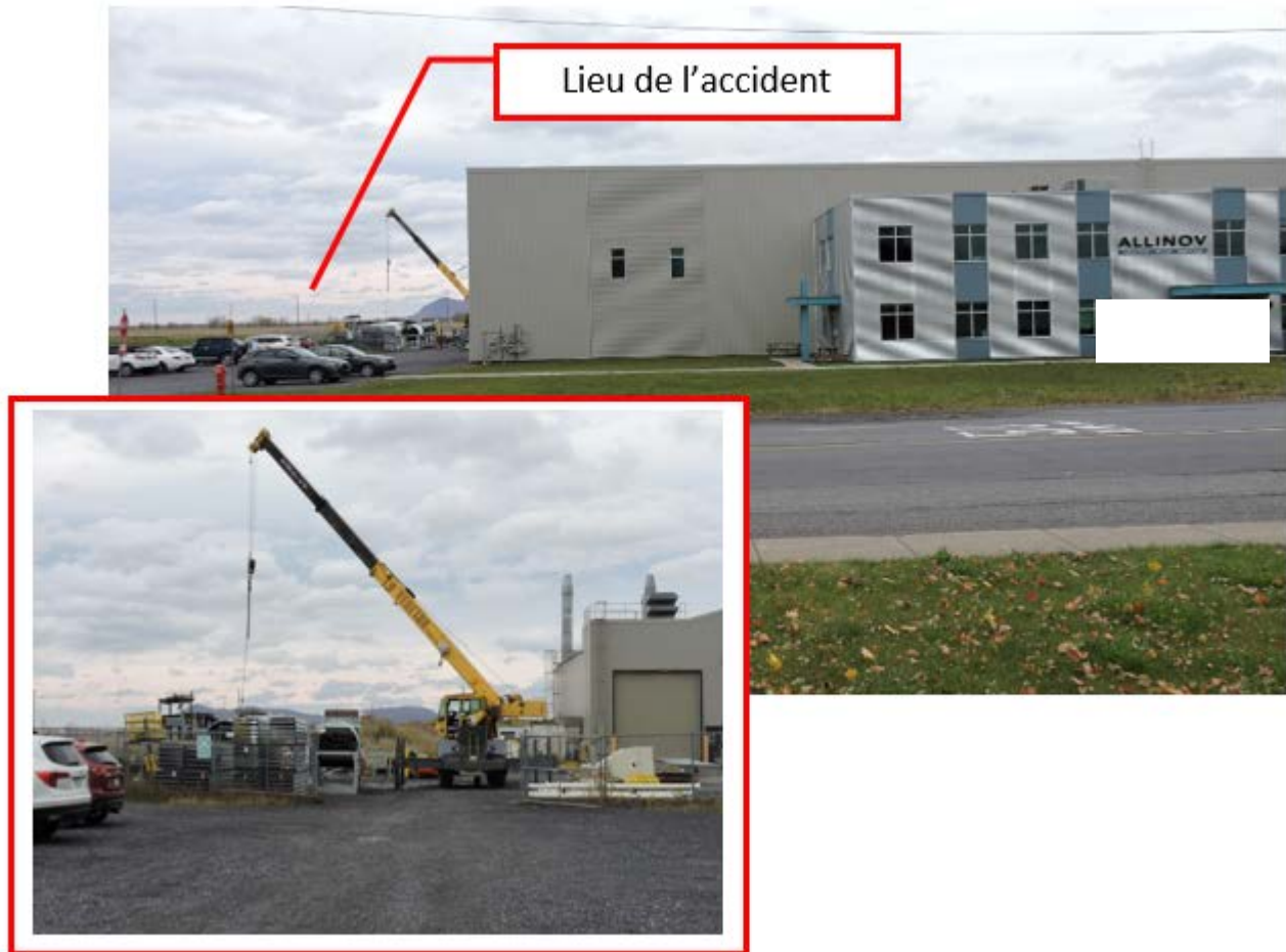
Photo 2 : Lieu de l'accident Source : CNESST
