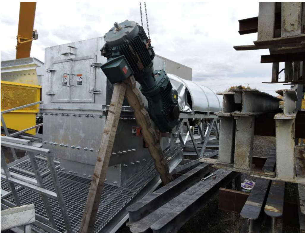
Photo 1 : Scène de l'accident à l'arrivée de la CNESST Source : CNESST
