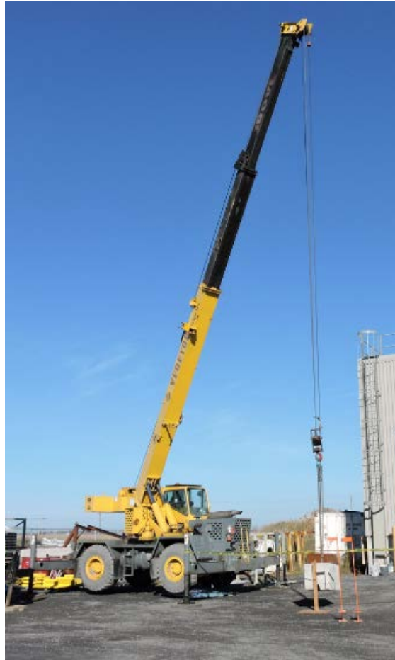
Photo 1 : Test de charge de la grue Source : CNESST
