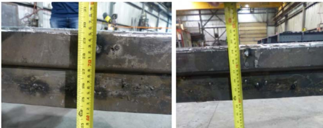
Photo n° 3-4 : exemples de mesures de positionnement des points de soudure effectués sur place Source : CNESST
