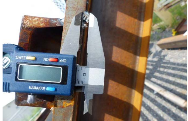
Photo 8 : Point de soudure sur la passerelle Source : CNESST
