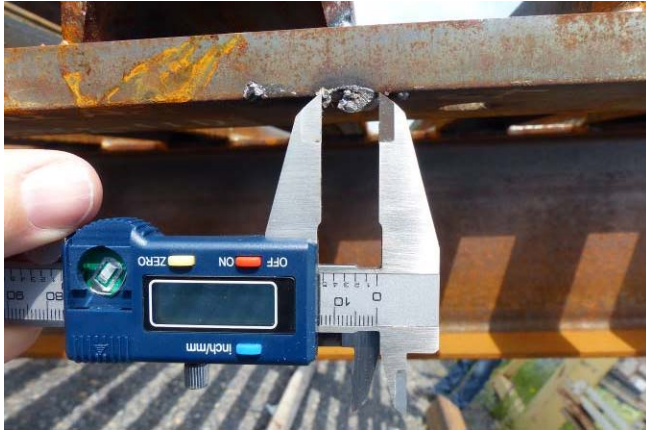
Photo 7 : Point de soudure sur la passerelle Source : CNESST
