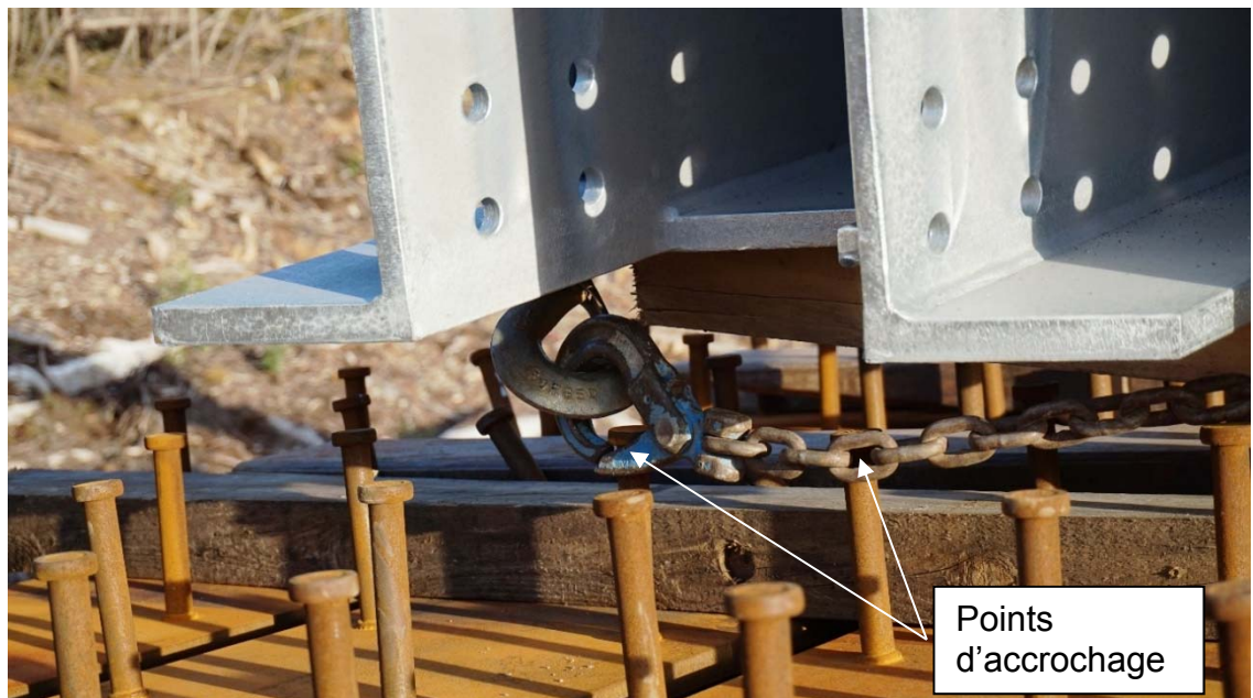
Photo 8 – Crochet et chaîne accrochés à deux goujons
