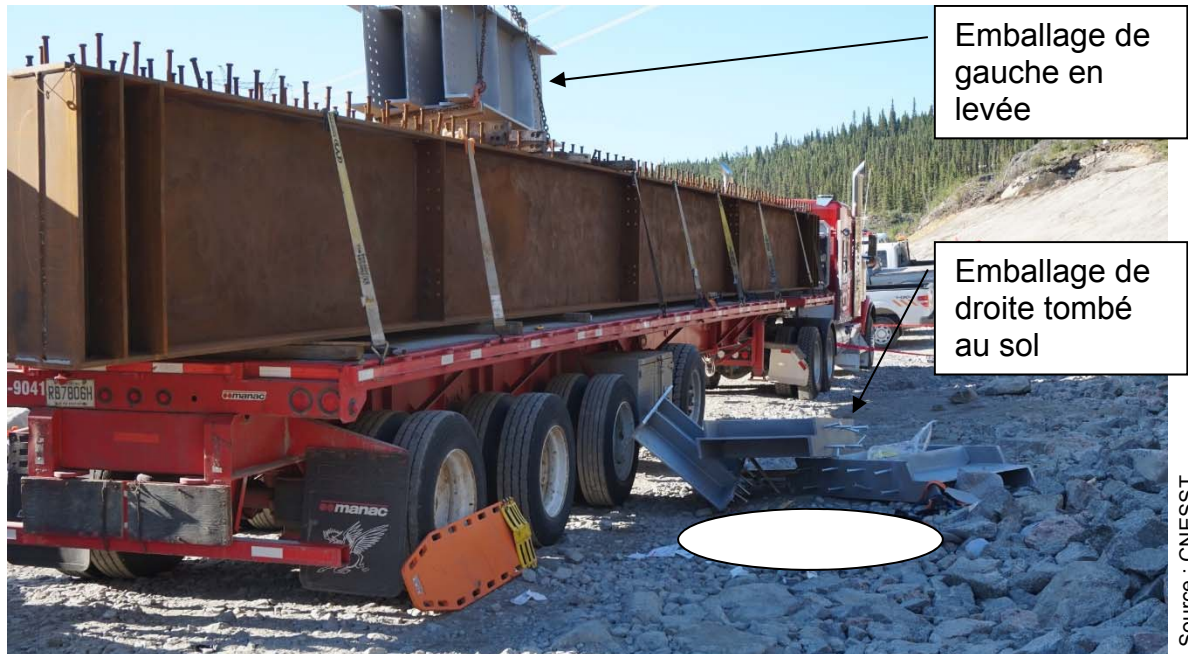
Photo 5 – Emplacement du travailleur au sol
