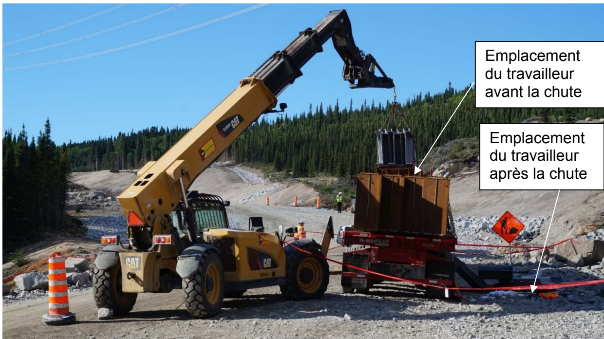
Photo 1 – Lieu de l'accident
