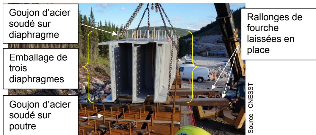
Photo 3 – Diaphragmes, goujons et poutres
