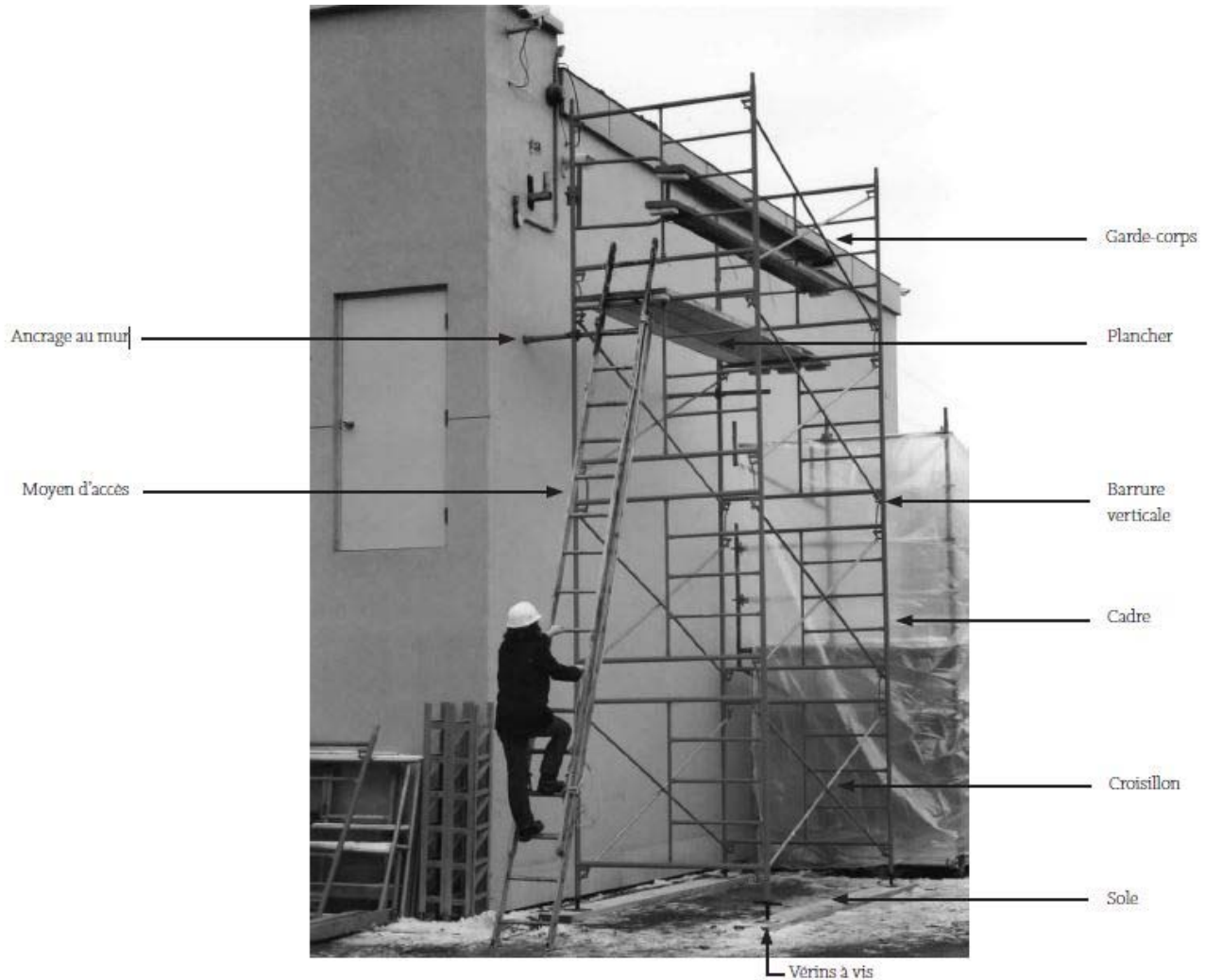
Photo 5 : Composants des échafaudages sur cadres métalliques (Source : CNESST)
