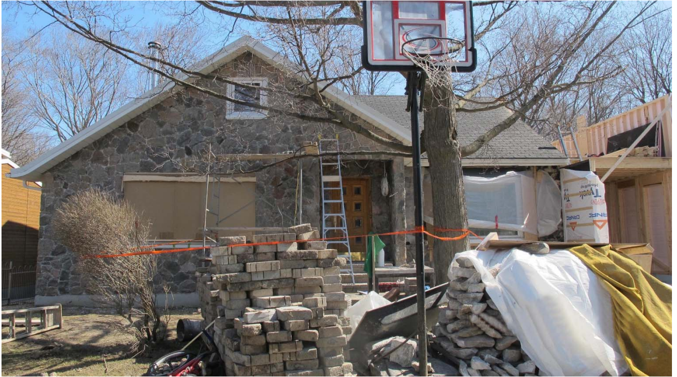
Photo 3 : Travaux de maçonnerie (Source : CNESST)
