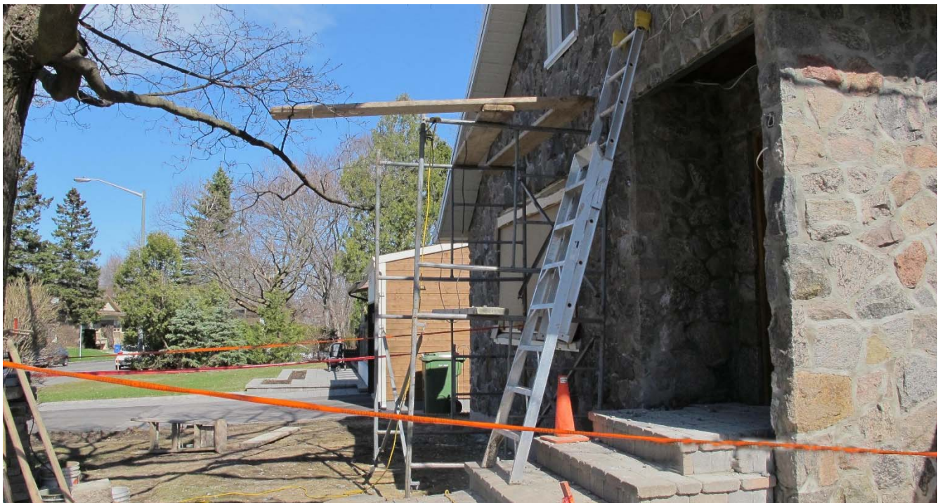
Photo 1 : Lieu de l'accident (Source : CNESST)
