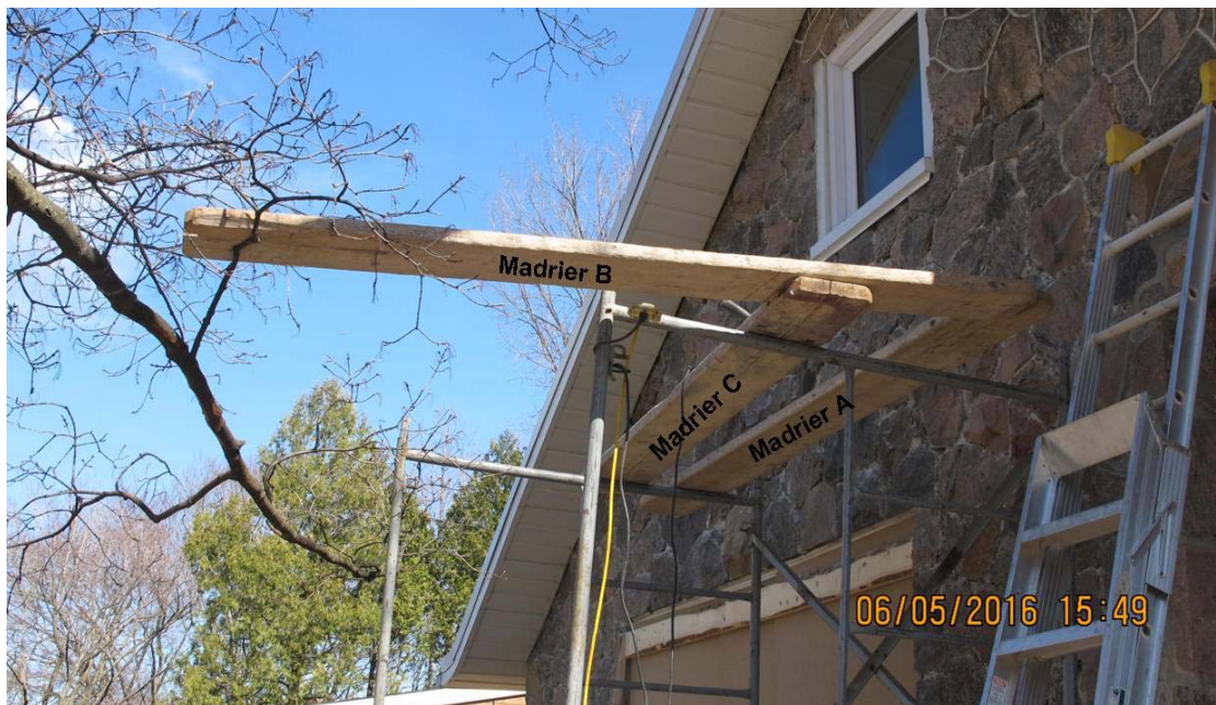
Photo no1 : Plancher de travail installé sur l'échafaudage (source CNESST)
