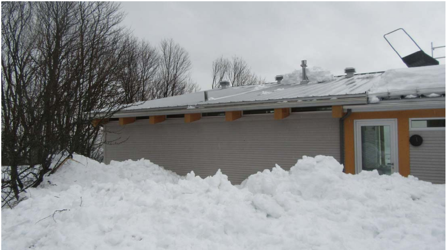
Photo 1 – Lieu de l'accident Source CNESST
