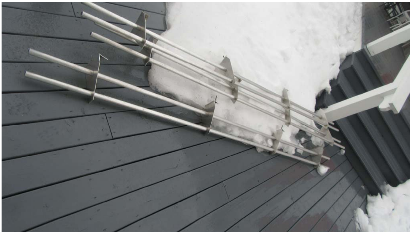
Photo 7 – Garde-neige à barreux arrachés du toit incliné
