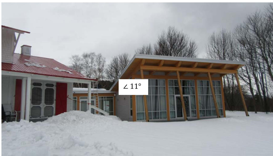
Photo 4 – Vue avant de l'annexe Source CNESST
