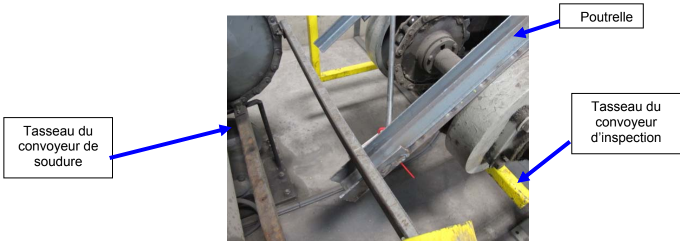
Photo n° 4 : Zone de transfert entre le convoyeur de soudure et le convoyeur d'inspection
