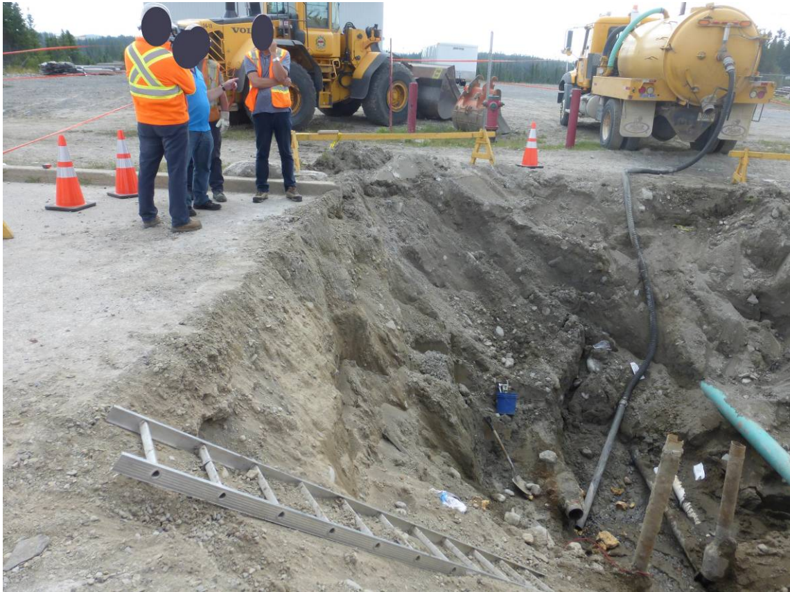
Photo 2 : Vue de la tranchée Source : CNESST
