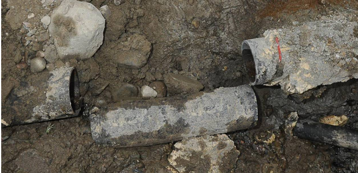
Photo 3 : Point de raccordement pour la nouvelle conduite d'aqueduc Source : Sûreté du Québec, modifiée CNESST
