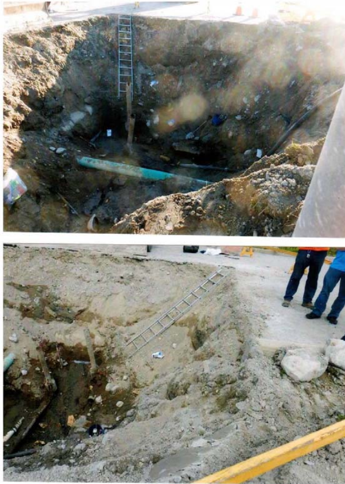
Figure 1 : Photographies montrant la zone excavée où s'est produit l'accident du 1er septembre 2015. La victime était en train de finaliser la 2 ème coupe d'un tuyau d'aqueduc en fonte lorsque la découpeuse aurait soudainement cabré ou bondi en direction de l'opérateur. Photos prises par la CSST
