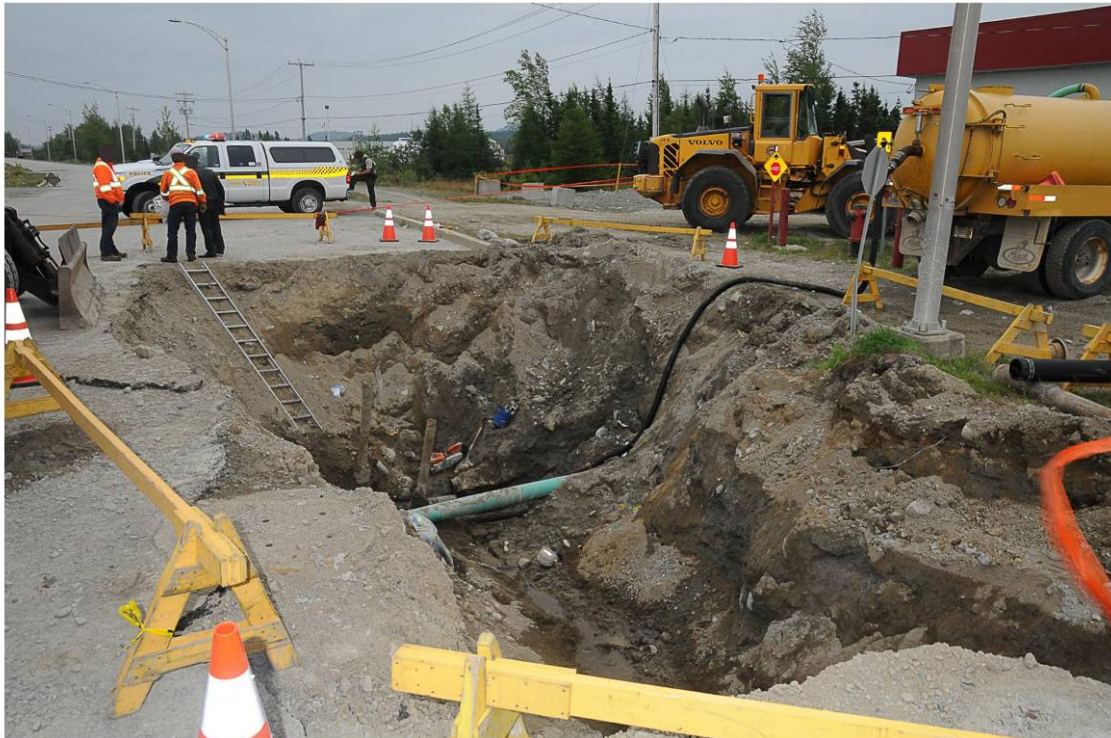
Photo 1 : Lieu de l'accident Source : Sûreté du Québec
